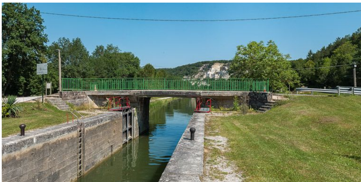
Le pont vu du sas.
