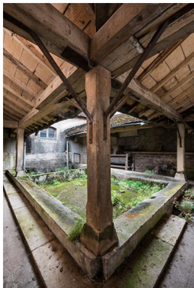
Le lavoir est sa galerie couverte Phot. Jérôme Mongreville IVR43_20167001481NUC4A
