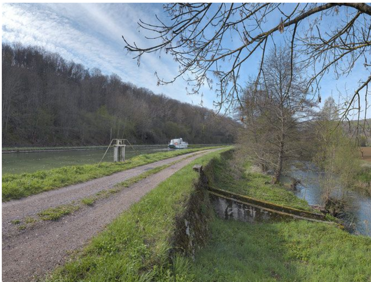
Le déversoir vu du chemin de halage.
