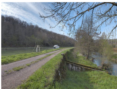
Le déversoir vu du chemin de halage.
