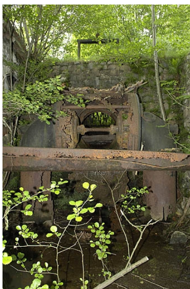
Vue d'ensemble de la turbine hydraulique. Phot. Jérôme Mongreville IVR43_20057000285NUCA
