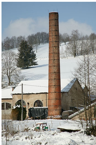
Salle des machines et sa cheminée. Phot. Jérôme Mongreville IVR43_20057000326NUCA
