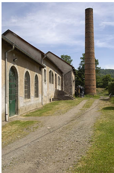
Alignement des façades postérieures. Phot. Jérôme Mongreville IVR43_20057000296NUCA
