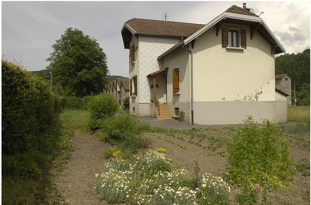
Logement de contremaître. Vue de trois quarts.
