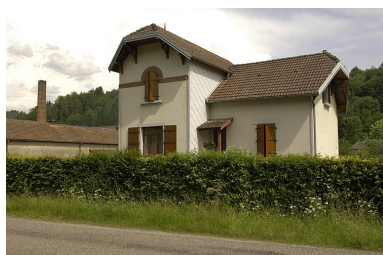
Logement de contremaître. Phot. Jérôme Mongreville IVR43_20057000305NUCA
