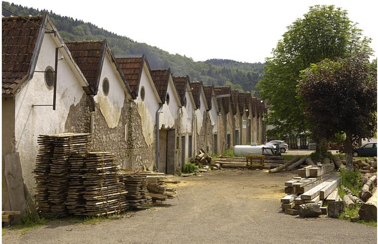
Pignons ouest de l'atelier de fabrication.
