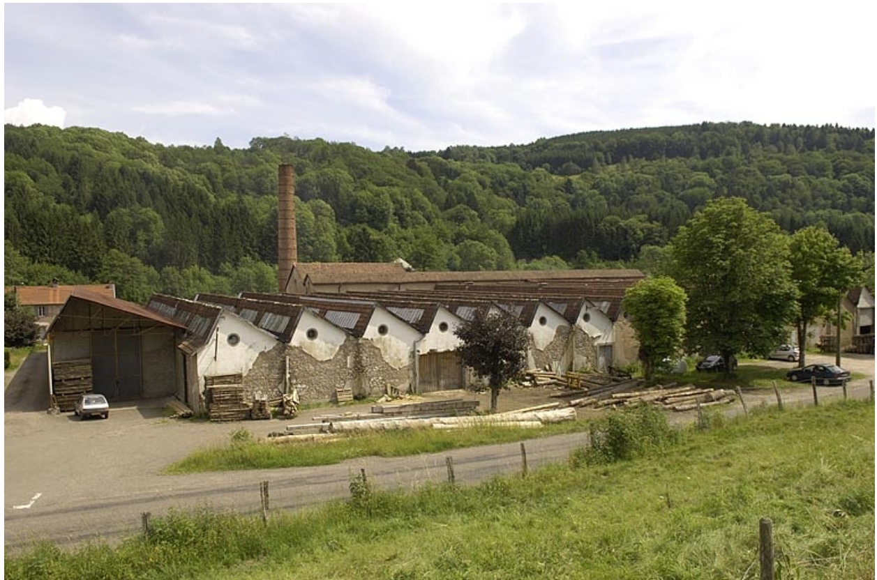
Vue plongeante sur les ateliers de fabrication.
