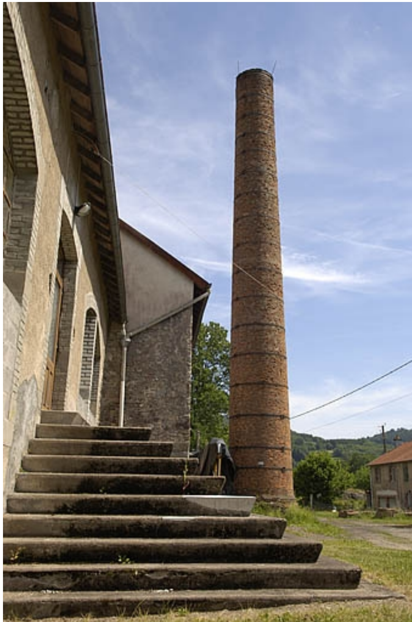
Escalier sur la façade postérieure et cheminée.
