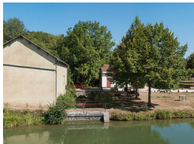
Détail d'un déversoir en aval du port.
