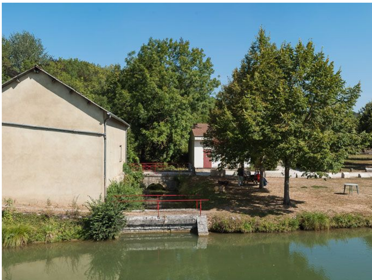
Détail d'un déversoir en aval du port.
