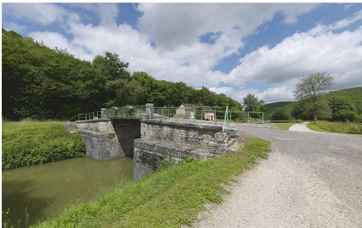
Pont vu de l'aval.
