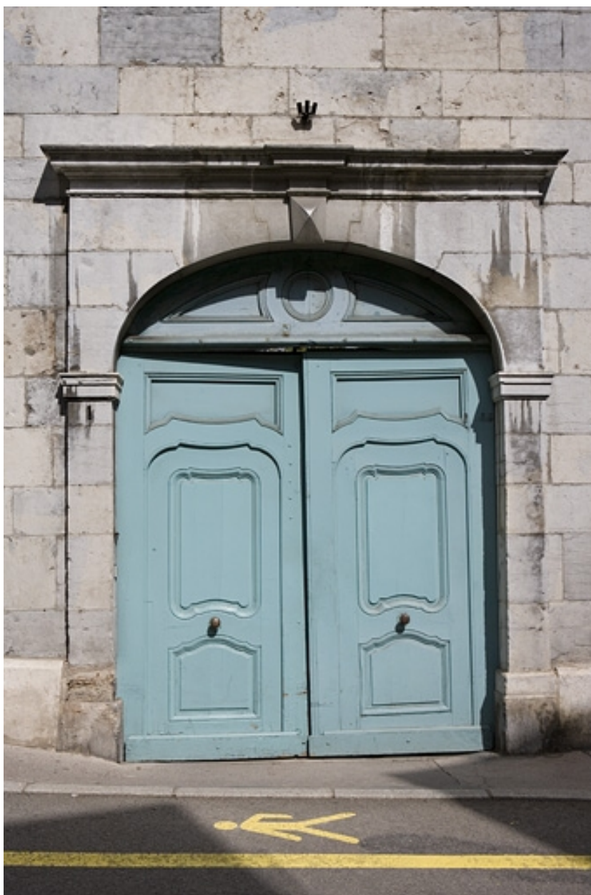
Détail du portail d'entrée sur rue.
