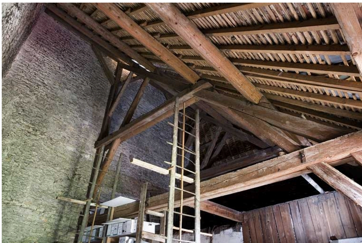
Vue du grenier à foin sur l'écurie.
