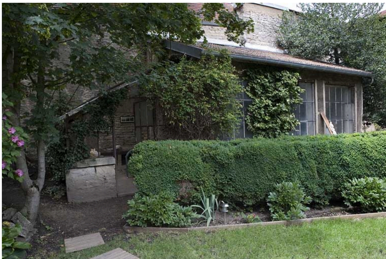
Vue d'ensemble de la serre.
