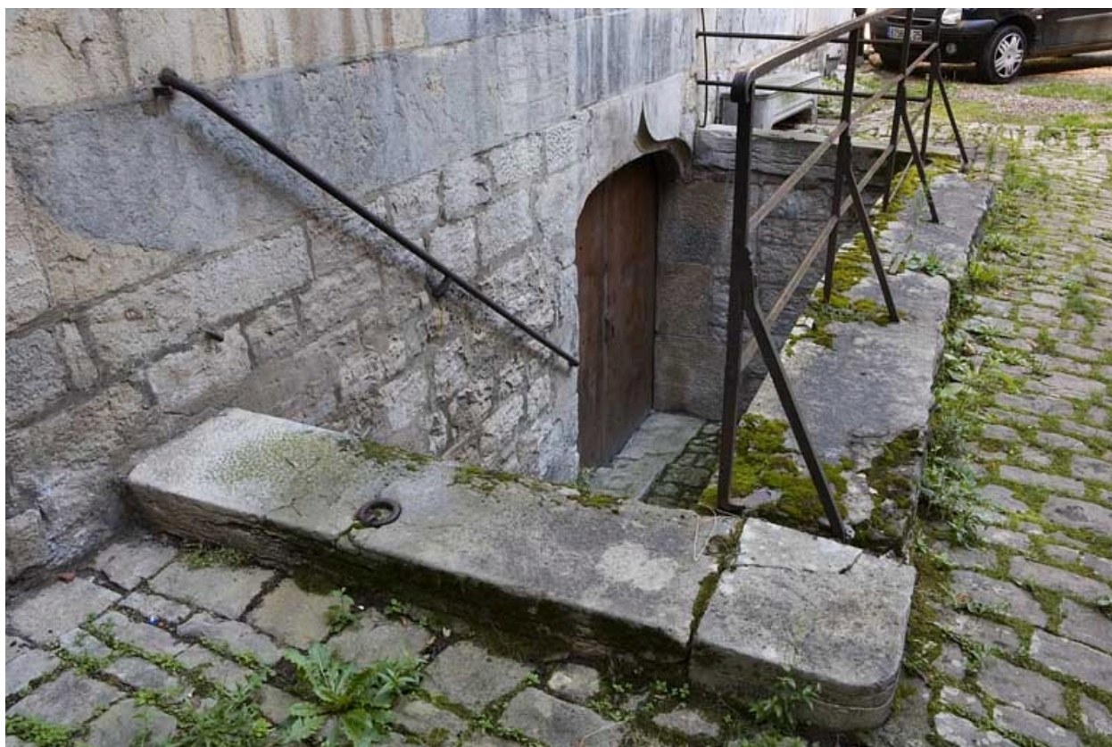
Logis principal : détail de l'entrée du sous-sol.
