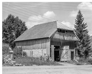
La remise, vue de trois quarts. Phot. Dominique Dominguez IVR43_19792500976X
