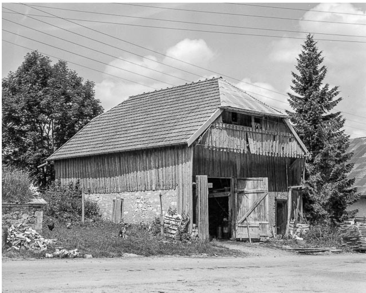
La remise, vue de trois quarts.
