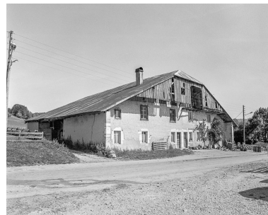
La ferme, vue de trois quarts gauche. Phot. Dominique Dominguez IVR43_19792500905X
