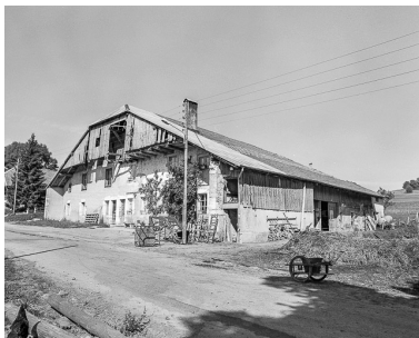
Vue d'ensemble, de trois quarts droit. Phot. Dominique Dominguez IVR43_19792500977X
