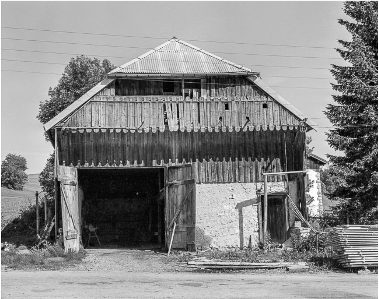
La remise, vue de face.
