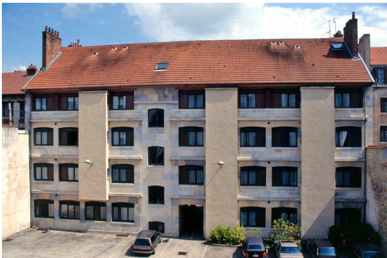
Façade postérieure en 1996.
