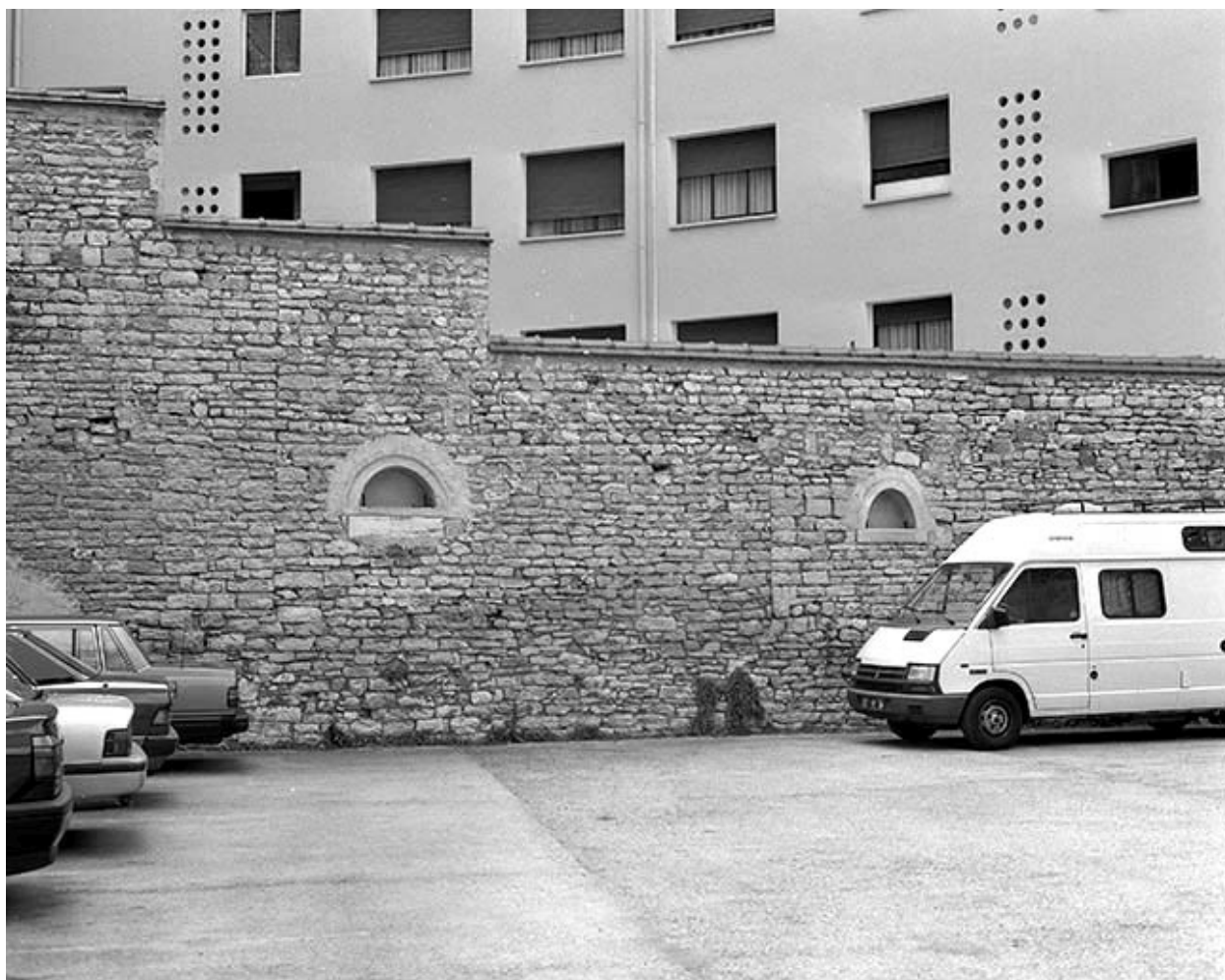
La cour en 1996. Détail du mur de clôture ouest.
