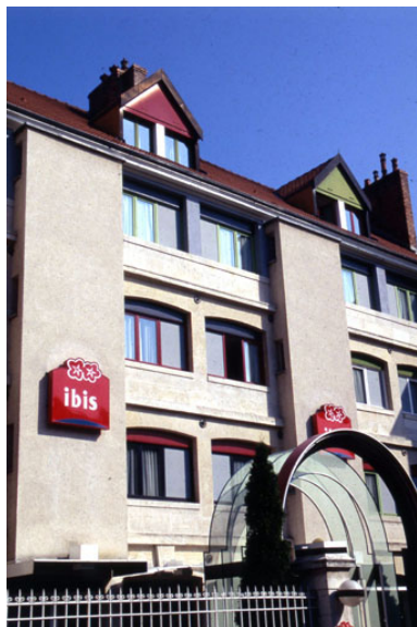
Détail de la façade antérieure en 1996. Phot. Jérôme Mongreville IVR43_19962500139ZA
