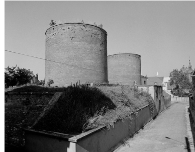
Vue des réservoirs depuis le revers. Phot. Yves Sancey IVR43_19887000113X
