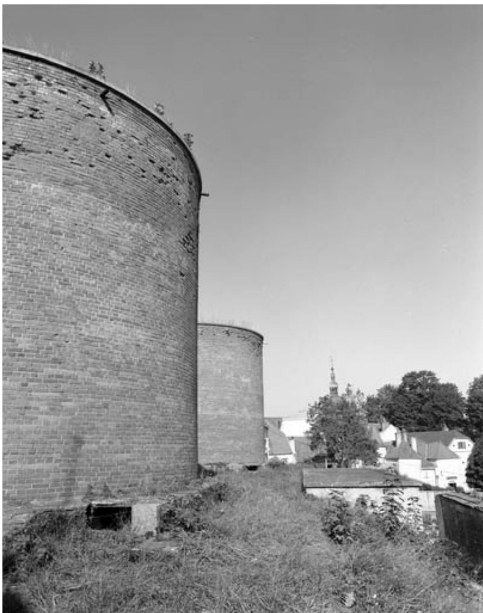
Les réservoirs : vue rapprochée.
