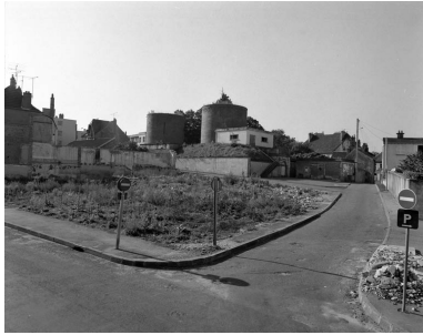
Vue d'ensemble éloignée. Phot. Yves Sancey IVR43_19887000112X
