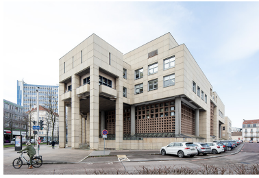
Façade sur la rue François-Mauriac, vue depuis l'est. Phot. Nicolas Waltefaugle IVR26_20262100126NUC4
