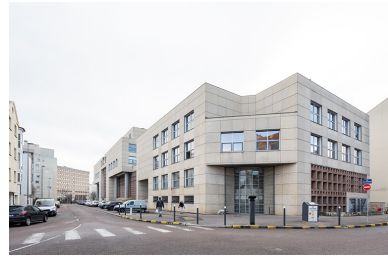
Façade sur la rue François-Mauriac, vue depuis l'ouest. Phot. Nicolas Waltefaugle IVR26_20262100135NUC4
