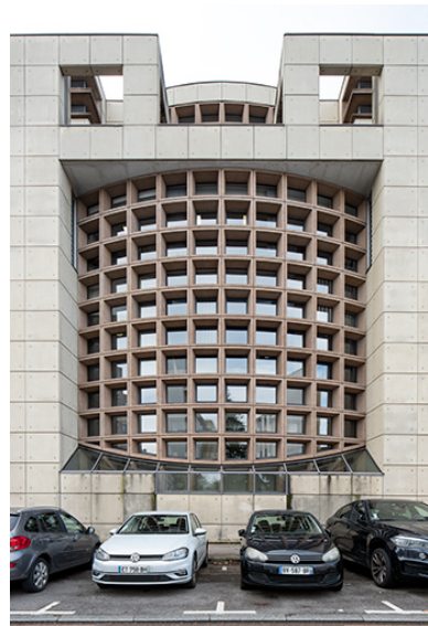
Façade sur la rue François-Mauriac, détail : baies de la salle d'audience du tribunal de grande instance. Phot. Nicolas Waltefaugle IVR26_20262100124NUC4
