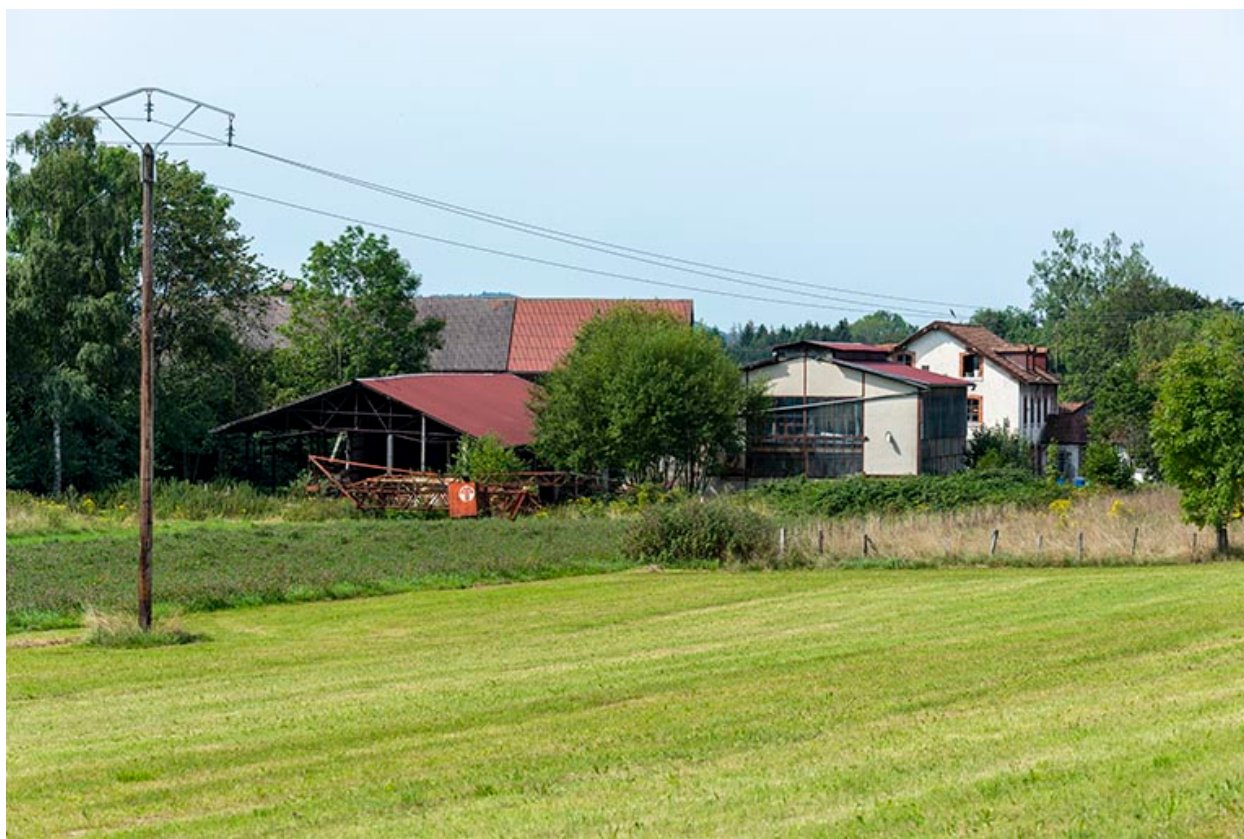
Vue d'ensemble du site, depuis le nord-est.
