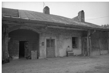
Façade latérale droite. Phot. Yves Sancey IVR43_19752500935Z
