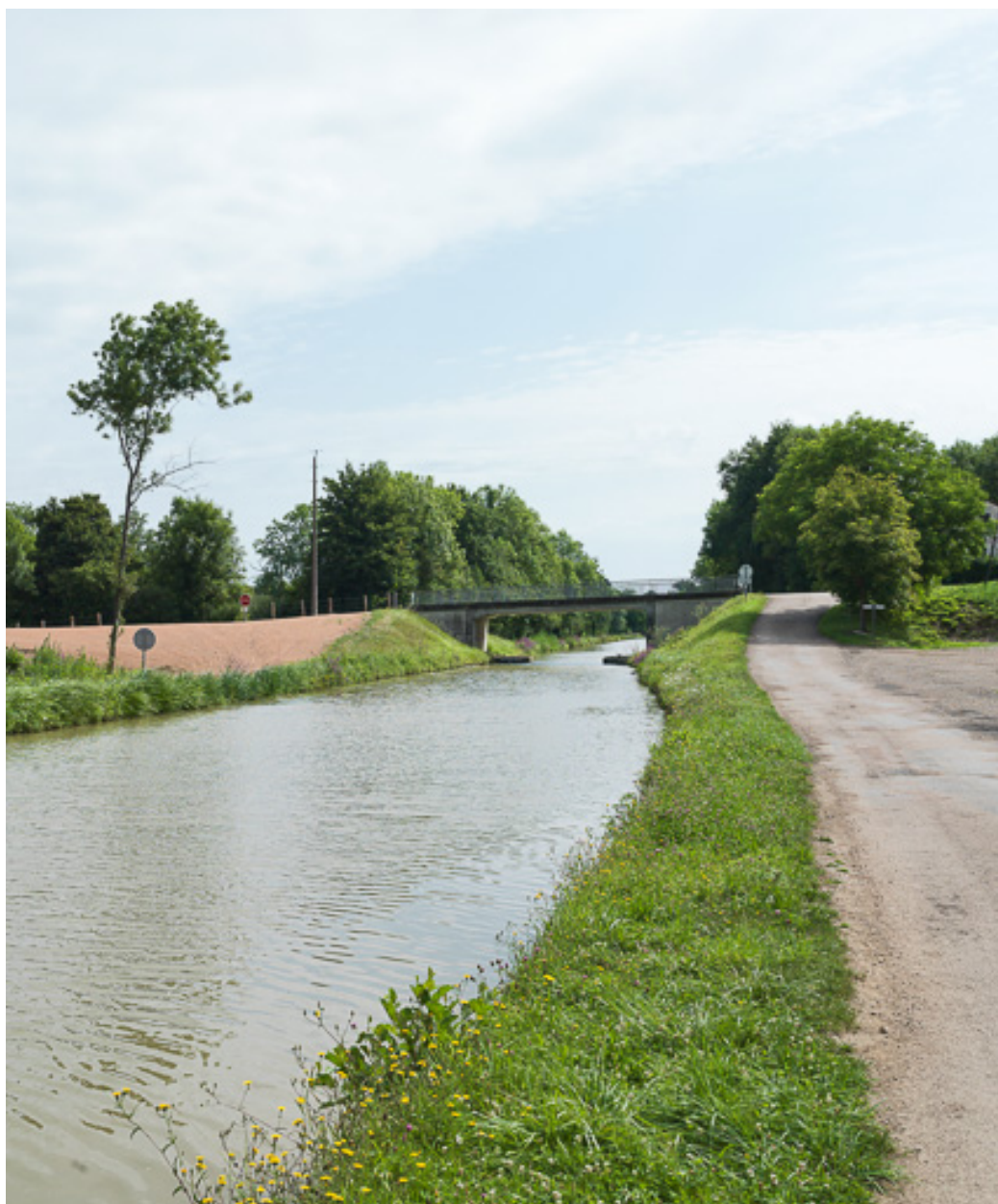
Vue d'ensemble du pont et du site.
