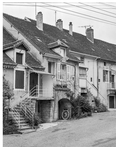
Macornay : maisons de vigneron. Phot. Yves Sancey IVR43_19843900235X
