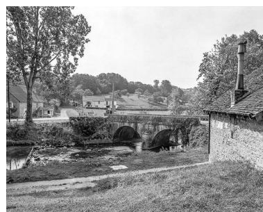
Chilly-le-Vignoble : pont sur la Sorne. Phot. Yves Sancey IVR43_19843900109X
