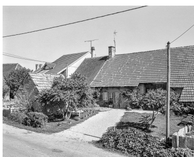
Condamine : ferme. Phot. Yves Sancey IVR43_19843900029X
