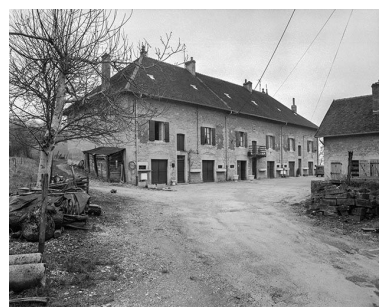
Montmorot : maison (lieudit Savagna). Phot. Jérôme Mongreville IVR43_19853900141X
