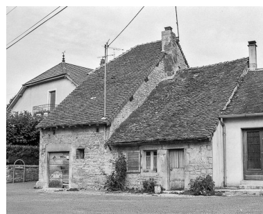
Messia-sur-Sorne : ferme. Phot. Yves Sancey IVR43_19843900266X
