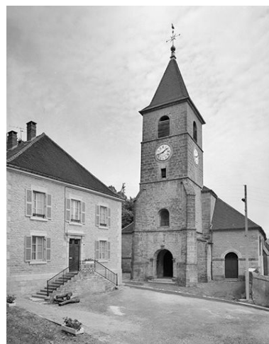
Montmorot : église Saint-Grégoire. Phot. Yves Sancey IVR43_19853900219V
