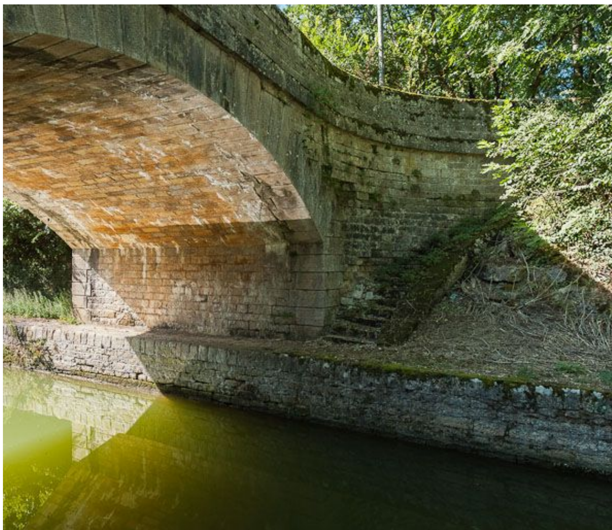
Détail de la voûte, de la culée et du parapet.
