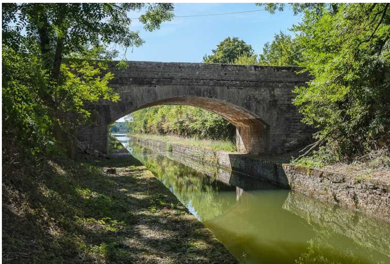
Vue du pont depuis l'amont.
