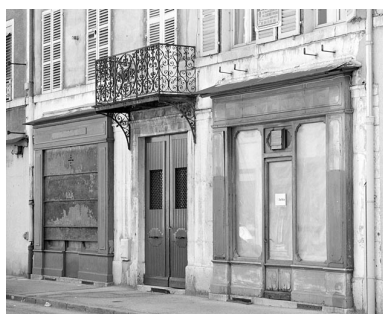
Boutiques au rez-de-chaussée. Phot. Yves Sancey IVR43_20033900482X
