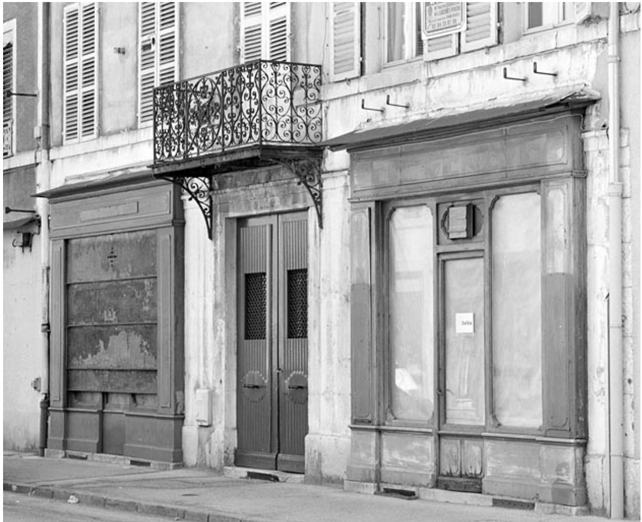
Boutiques au rez-de-chaussée.
