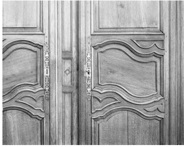
Détails des ferrures. Phot. Yves Sancey IVR43_19927000126X
