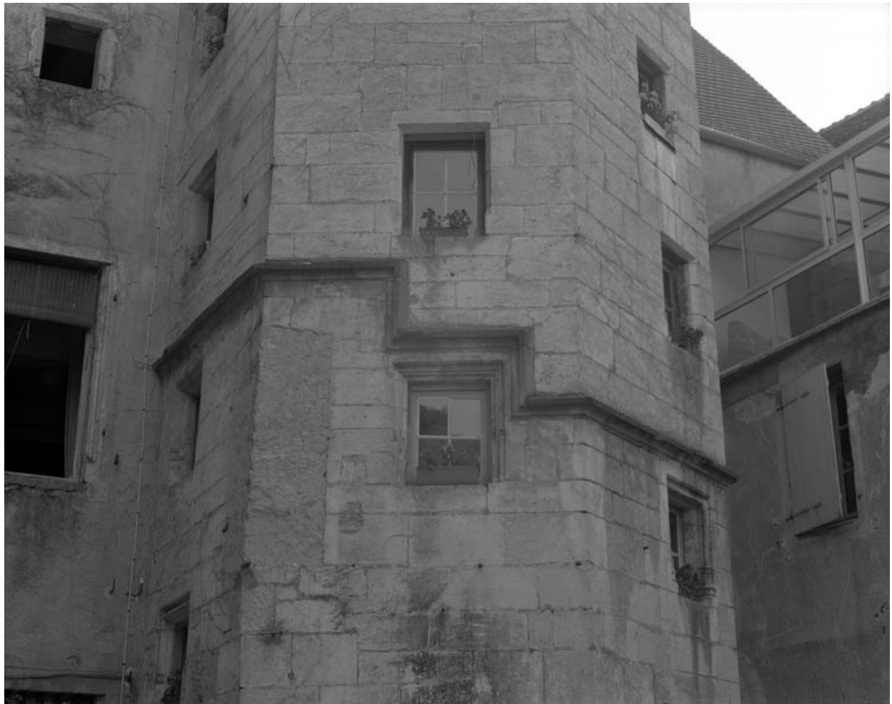
Façade postérieure. Détail : baies de l'escalier hors-oeuvre.
