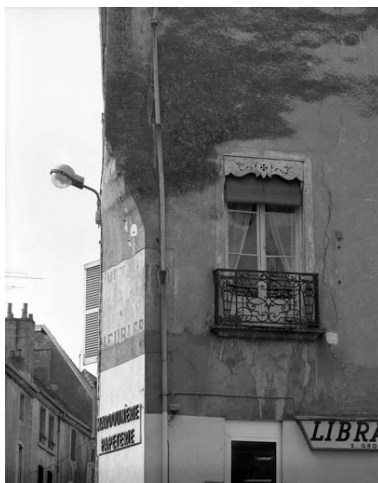
Détail : mur à angle coupé et en encorbellement entre la façade antérieure et la façade latérale droite. Phot. Yves Sancey IVR43_19897000149X
