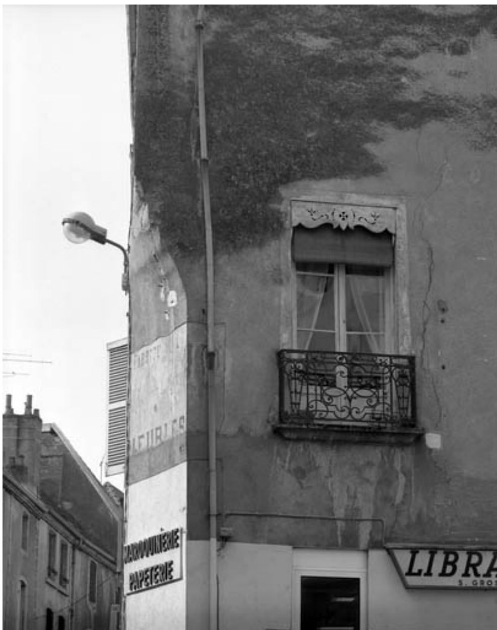
Détail : mur à angle coupé et en encorbellement entre la façade antérieure et la façade latérale droite.
