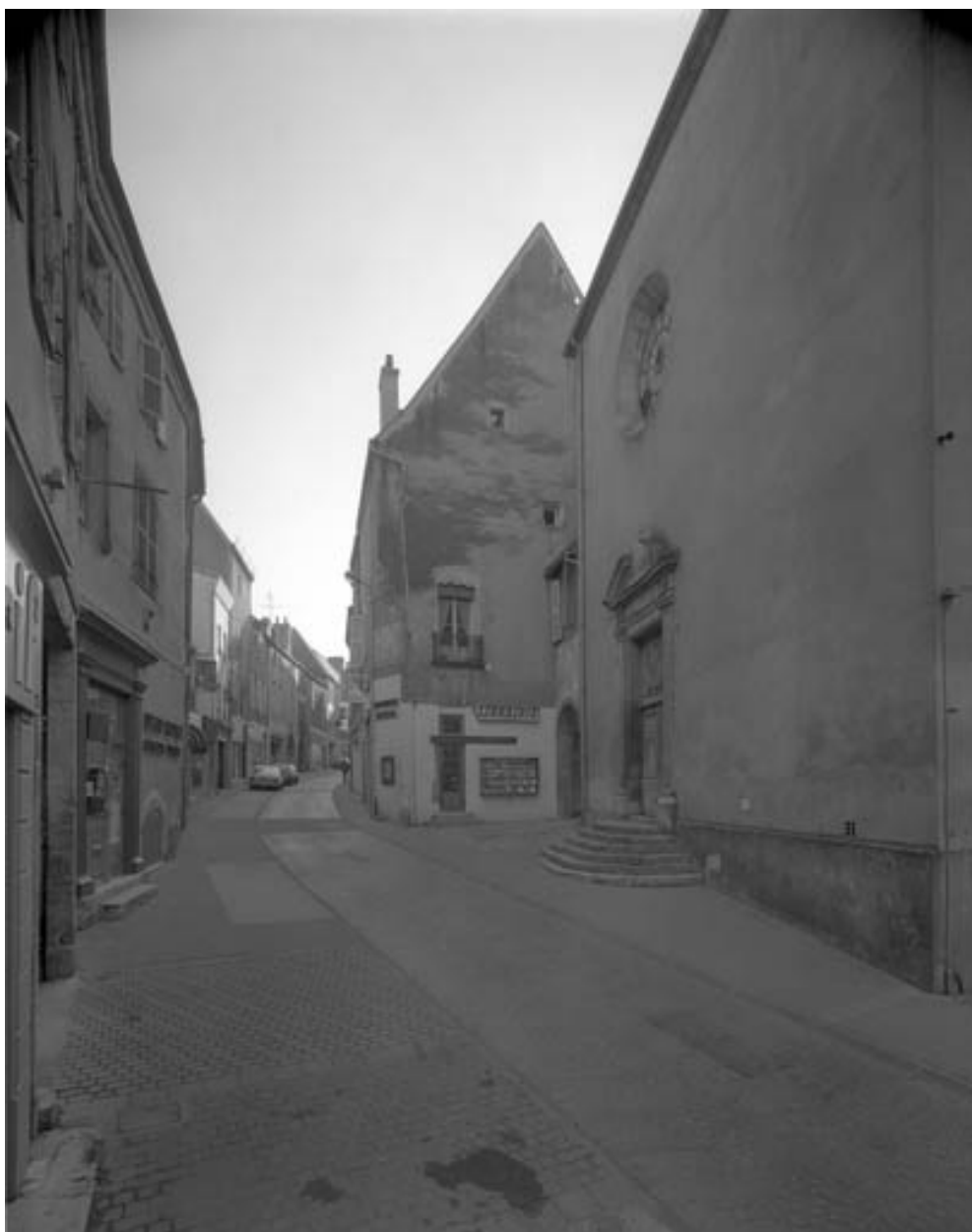
Façade latérale droite depuis la Grande rue.
