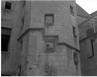
Façade postérieure. Détail : baies de l'escalier hors-oeuvre. Phot. Yves Sancey IVR43_19897000152X
