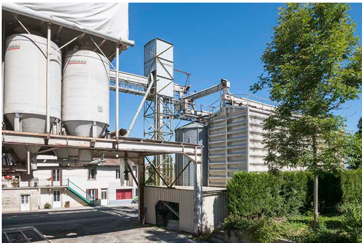
Silos et installations de chargement/déchargement.
