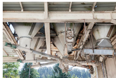
Trémies de chargement. Phot. Jérôme Mongreville IVR43_20162501157NUC4A
