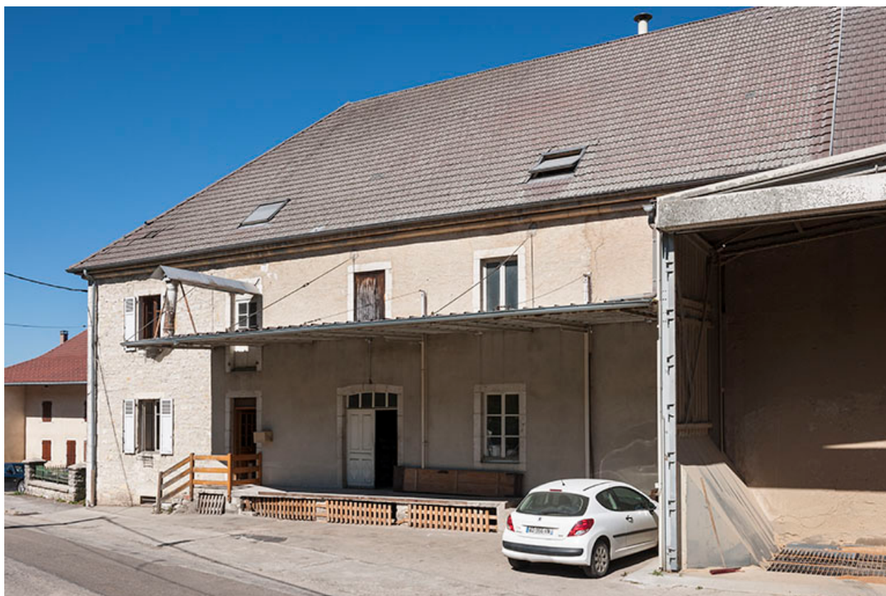
Façade sud-est de la minoterie.
