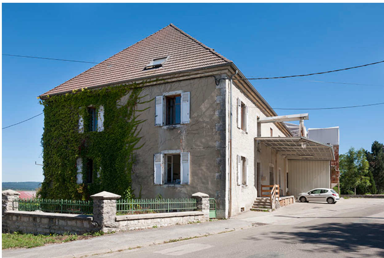
Extrémité sud du bâtiment : bureaux et logements.
