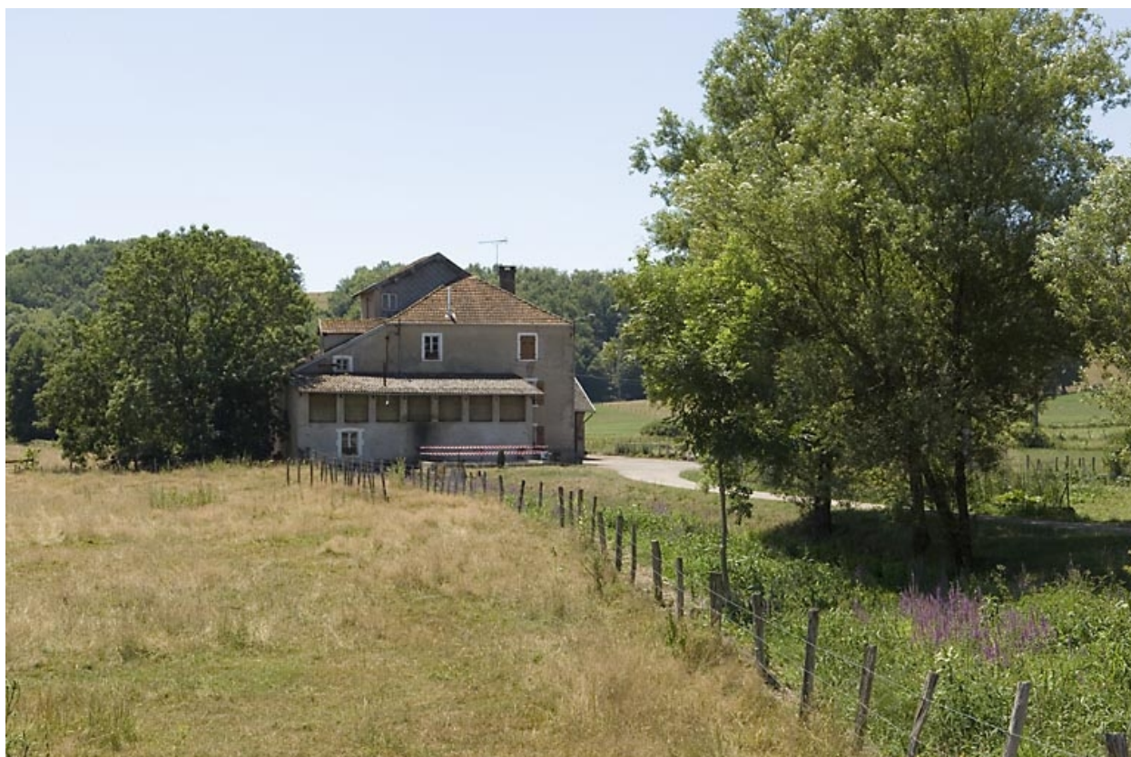
Vue depuis l'amont.
