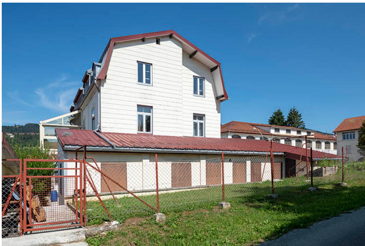
Façade latérale droite et atelier de fabrication.
