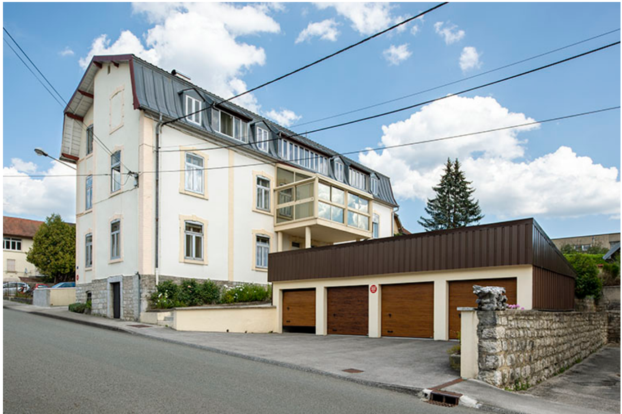
Façades antérieure et latérale gauche.
