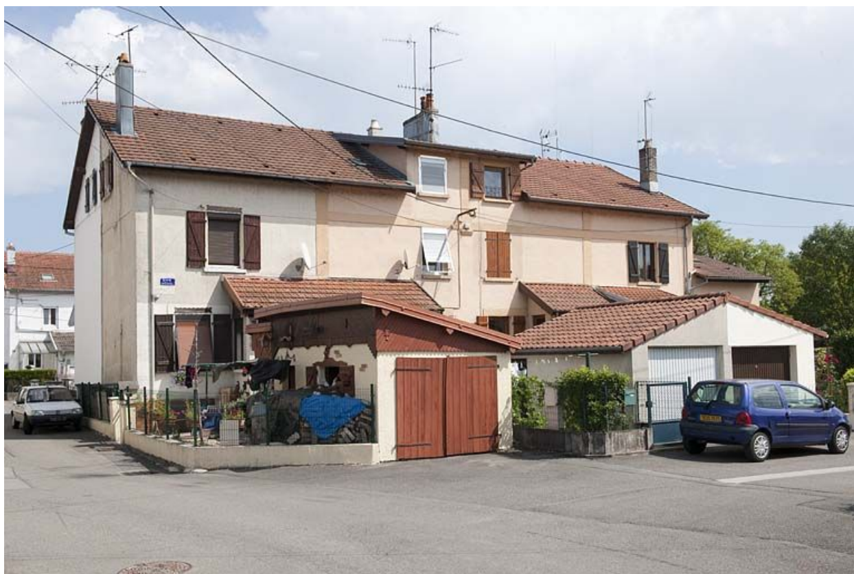
Habitation à 8 logements. Façade ouest.
