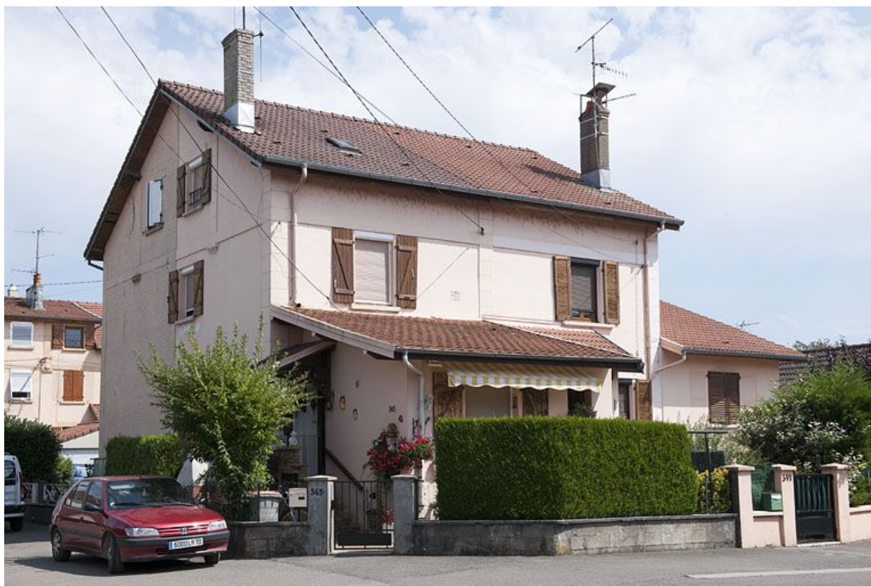
Habitation à 4 logements. Façade ouest.
