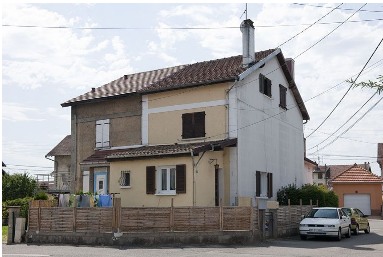
Habitation à 4 logements. Vue de trois quarts.
