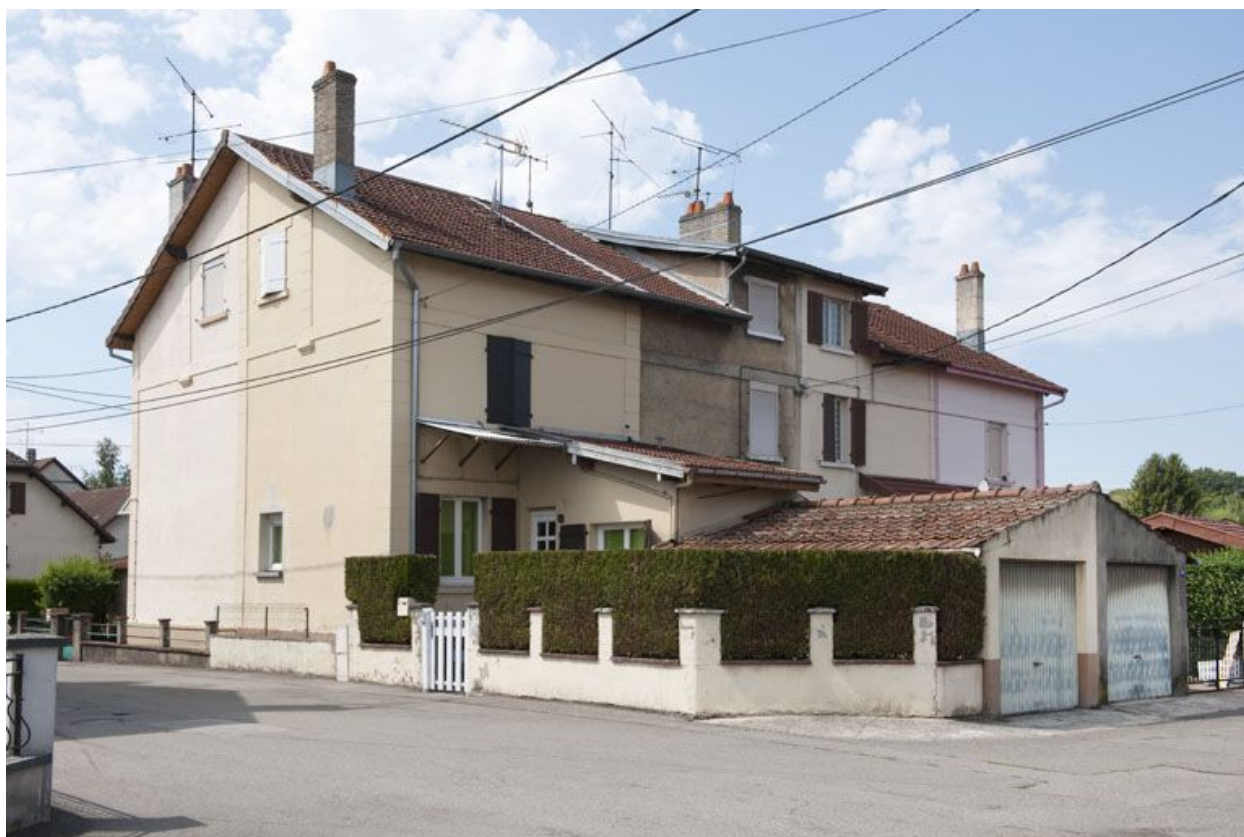
Habitation à 8 logements vue de trois quarts.
