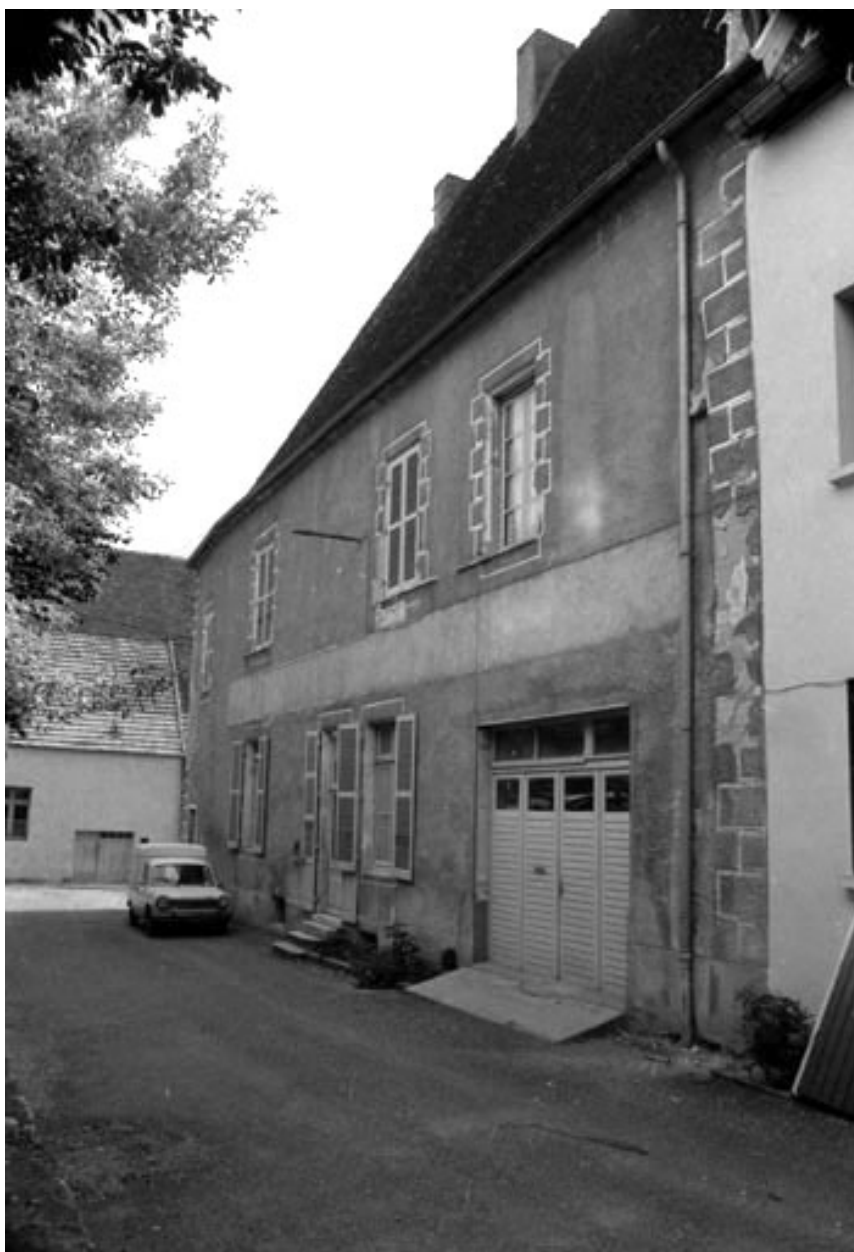
Maison du prieur : façade postérieure.
