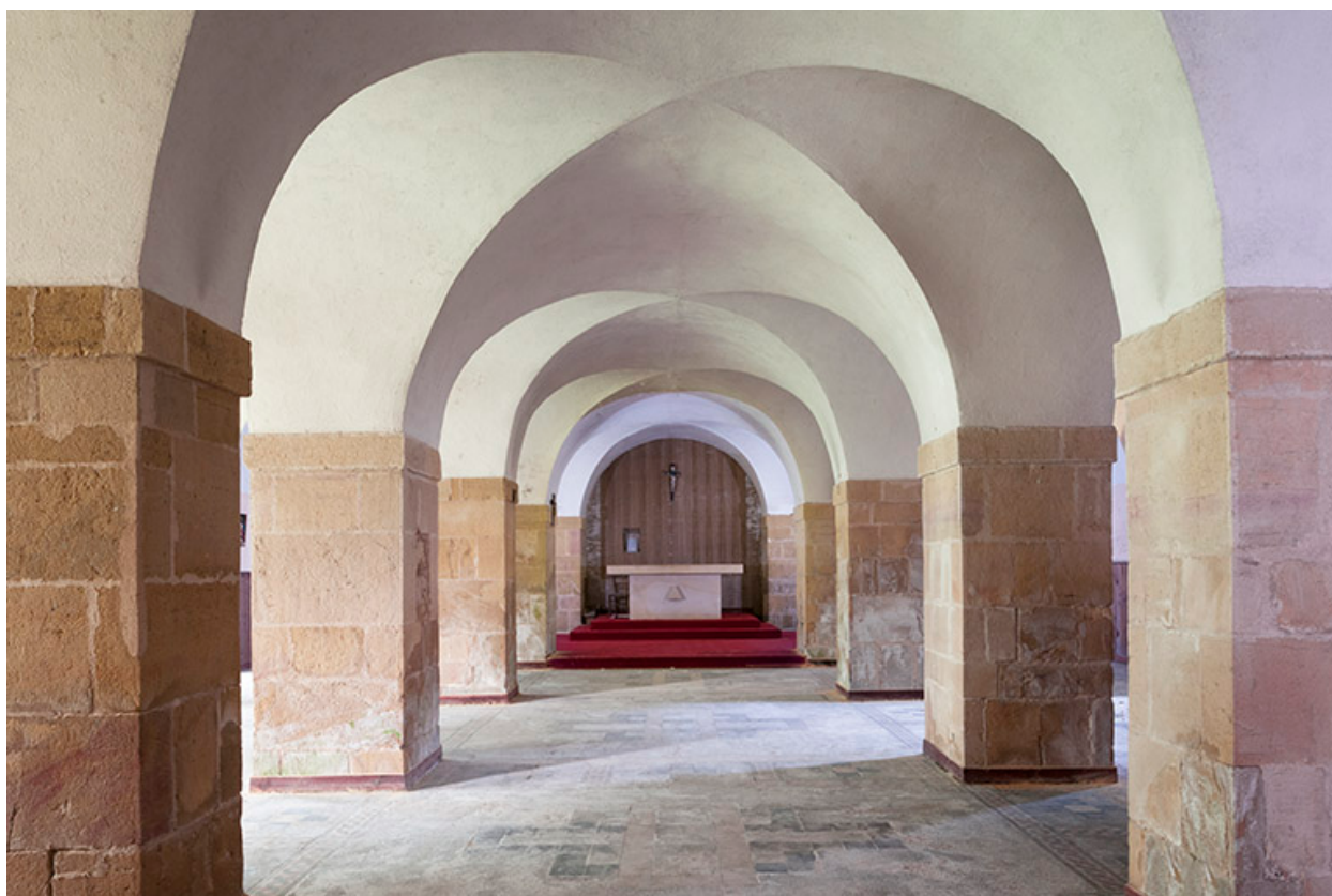
Intérieur : l'étage de soubassement aménagé en chapelle.
