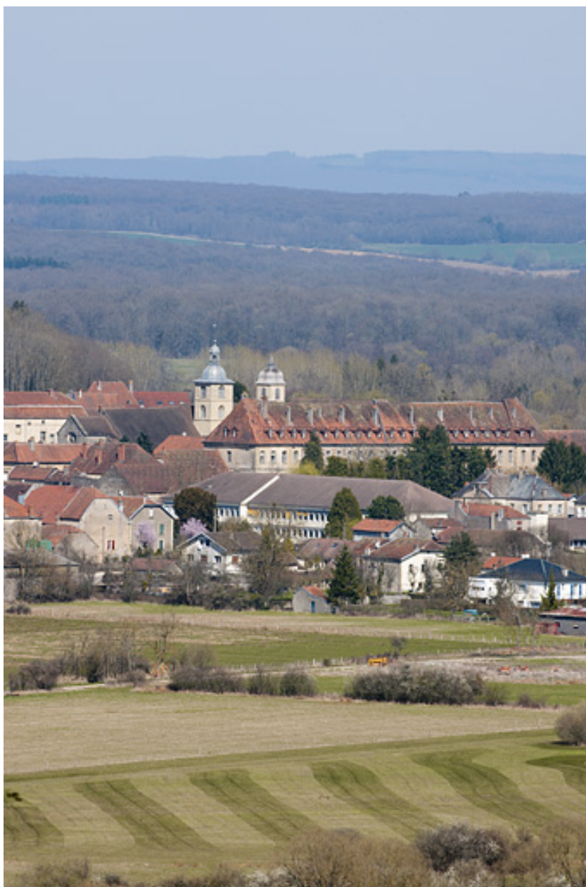
Vue générale rapprochée (depuis le sud-ouest).
