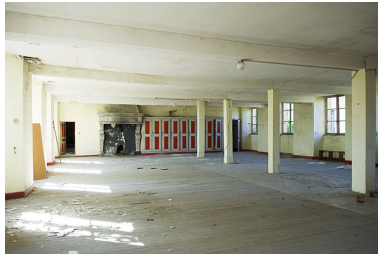
Intérieur : le réfectoire. Phot. Jérôme Mongreville IVR43_20127000152NUC2A
