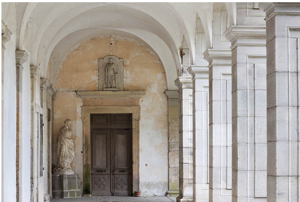
Vue rapprochée de la galerie sud.
