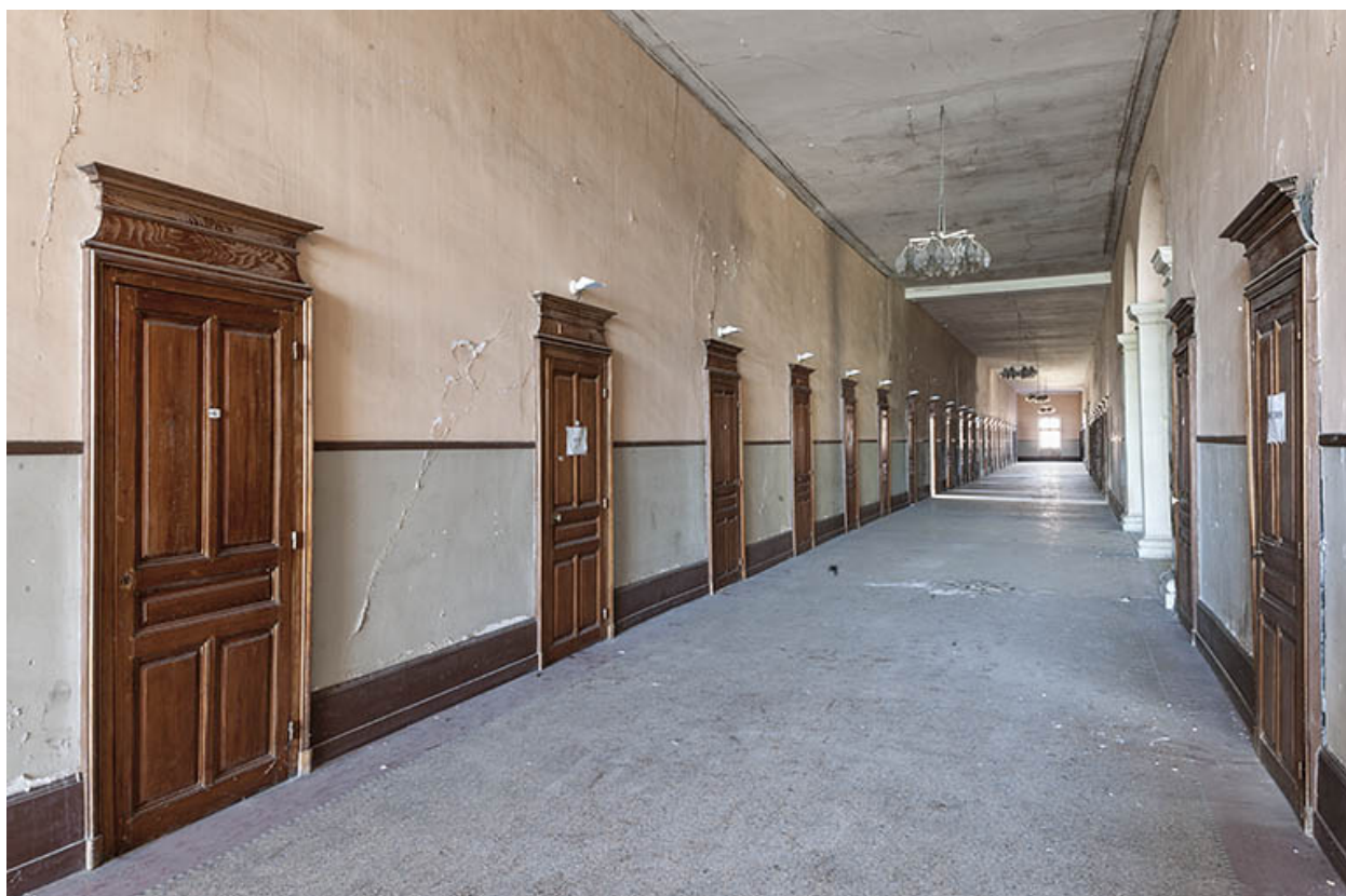
Intérieur : le couloir en direction de l'ouest.
