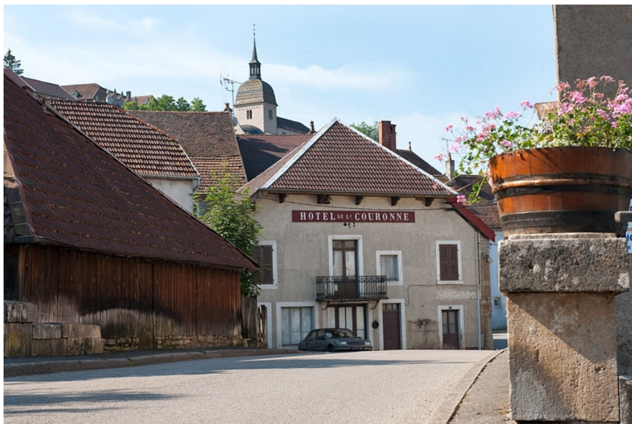
Vue générale éloignée.
