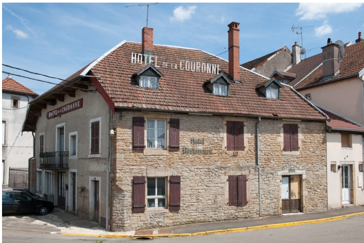
Façade antérieure et latérale droite.
