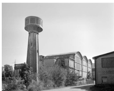
Le château d'eau et la centrale thermique.
