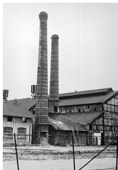
Démolition des 2 dernières cheminées. Phot. Jérôme Mongreville IVR43_19973900942X
