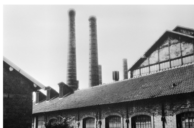
Façade postérieure du bâtiment des compresseurs. Phot. Jérôme Mongreville IVR43_19973901010X
