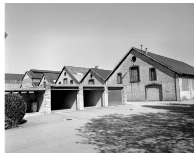
Pignons des ateliers de l'ancienne forge. Phot. Yves Sancey IVR43_19973901512X
