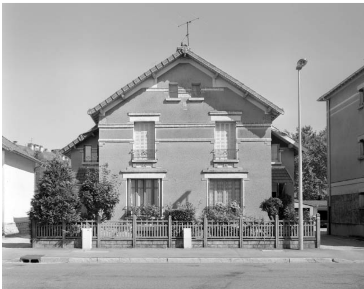
Façade antérieure d'un logement double (cadrage horizontal).
