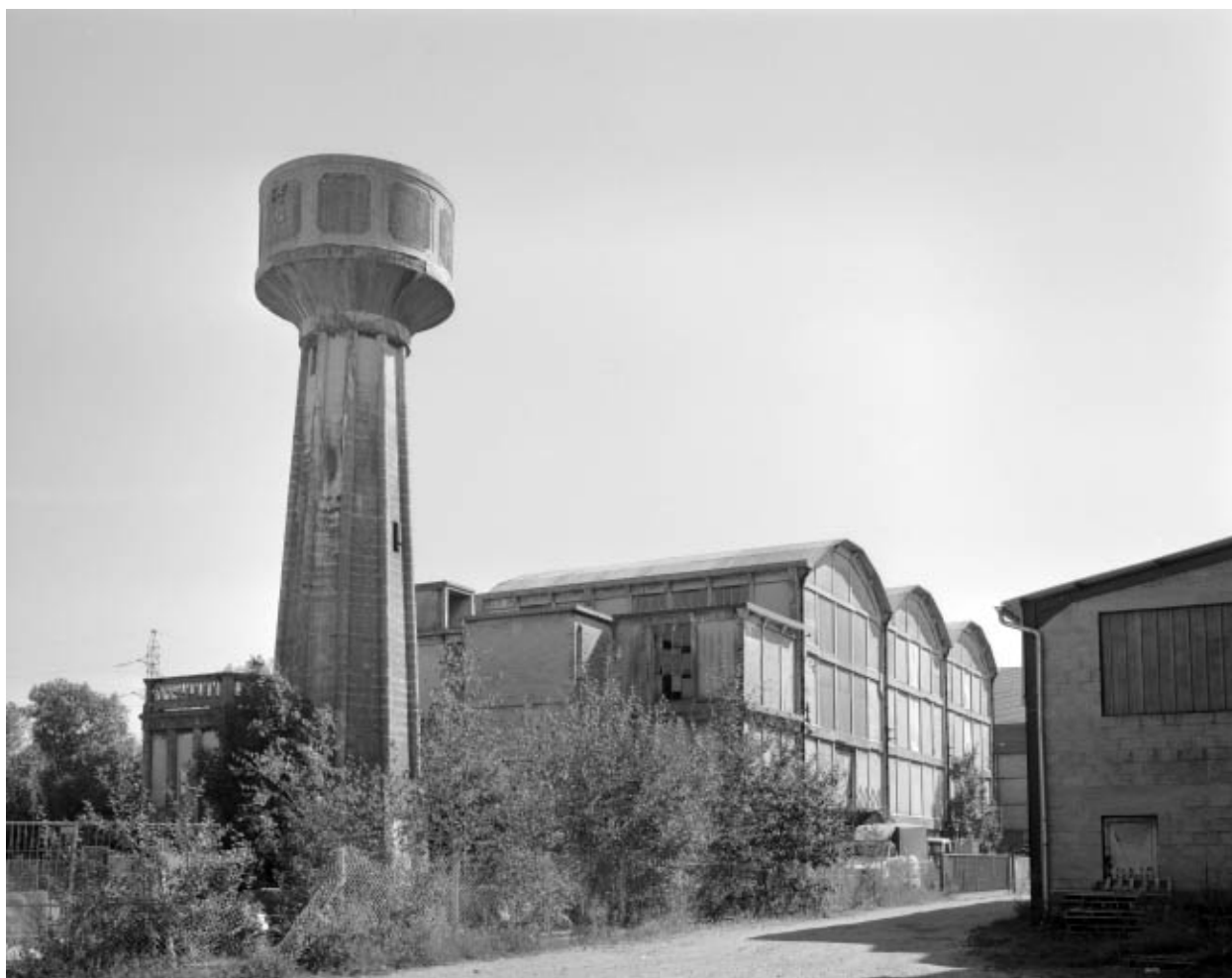
Le château d'eau et la centrale thermique.
