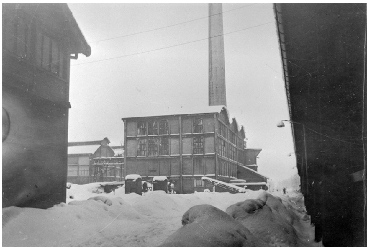
La centrale thermique depuis le sud-est.
