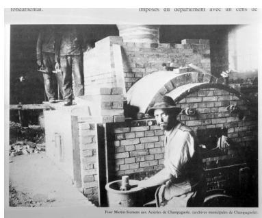
Four Martin-Siemens aux Aciéries de Champagnole. Phot. Jérôme Mongreville IVR43_19963900596X
