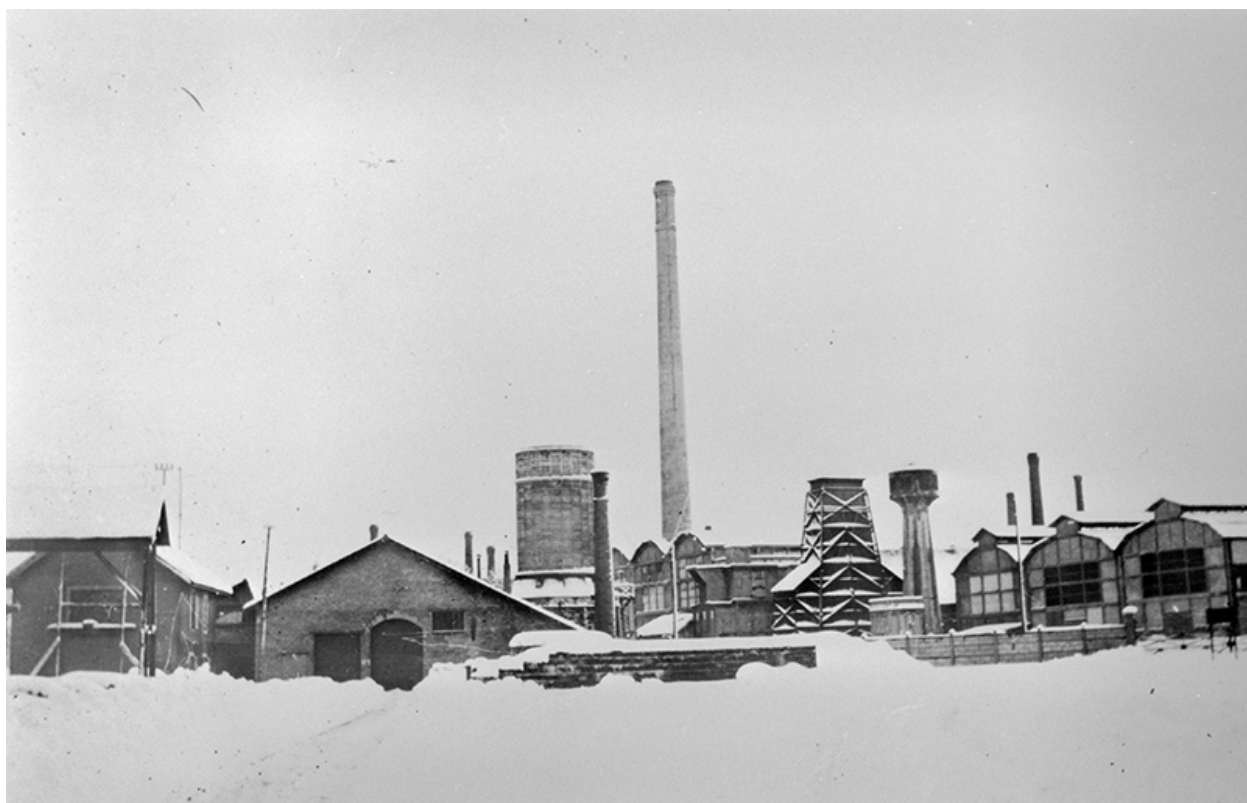
Vue d'ensemble des Aciéries depuis le nord.
