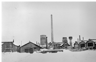
Vue d'ensemble des Aciéries depuis le nord. Phot. Jérôme Mongreville IVR43_19973901015X
