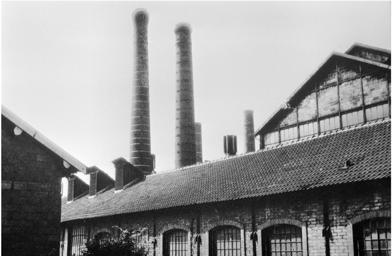
Façade postérieure du bâtiment des compresseurs.
