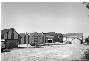
Façades postérieures des ateliers de l'ancienne forge. Phot. Yves Sancey IVR43_19973901516X
