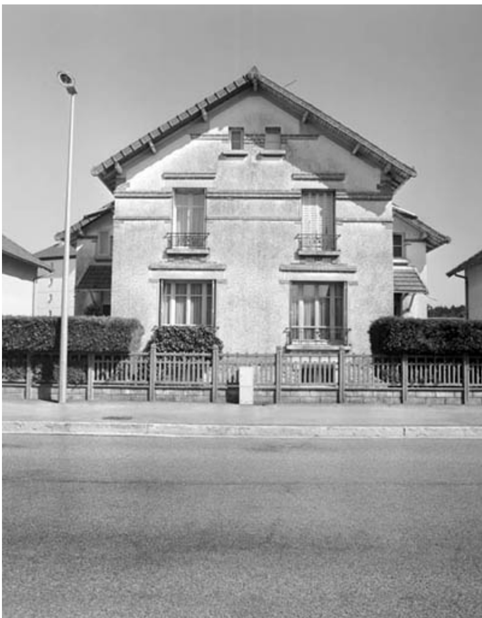
Façade antérieure d'un logement double (cadrage vertical).
