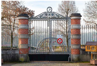
Clôture (grille) sur l'avenue des Pâtis. Phot. Jérôme Mongreville IVR43_20197000100NUC4A
