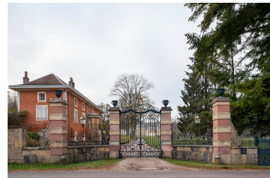
Clôture (grille) sur la rue de Saint-Albin. Phot. Jérôme Mongreville IVR43_20187000804NUC4A
