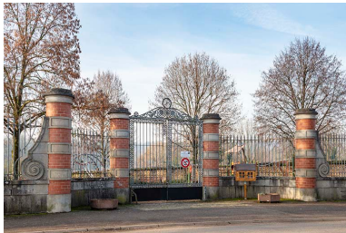
Clôture (grille) sur l'avenue des Pâtis. Phot. Jérôme Mongreville IVR43_20197000102NUC4A
