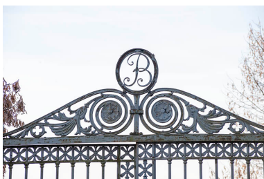
Clôture (grille) sur l'avenue des Pâtis. Phot. Jérôme Mongreville IVR43_20197000103NUC4A
