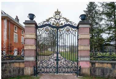
Clôture (grille) sur la rue de Saint-Albin. Phot. Jérôme Mongreville IVR43_20187000805NUC4A
