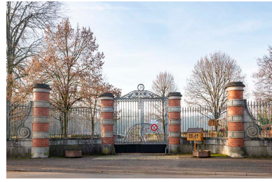
Clôture (grille) sur l'avenue des Pâtis. Phot. Jérôme Mongreville IVR43_20197000101NUC4A
