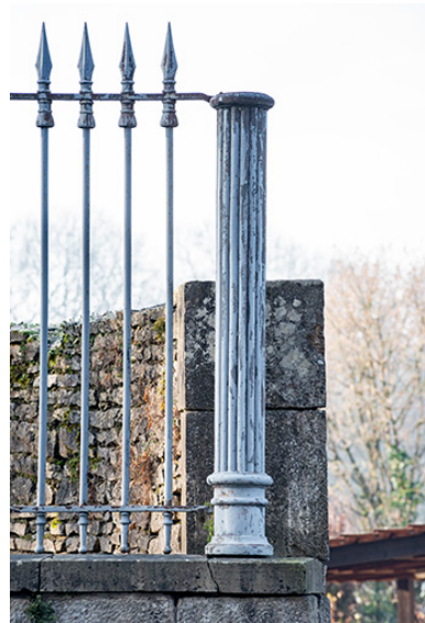
Clôture (grille) sur l'avenue des Pâtis. Phot. Jérôme Mongreville IVR43_20197000104NUC4A
