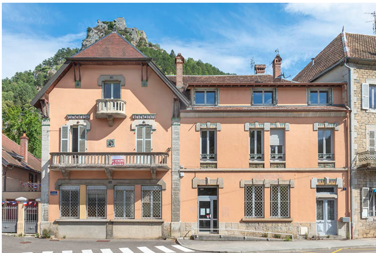
Vue de face (partie nord).
