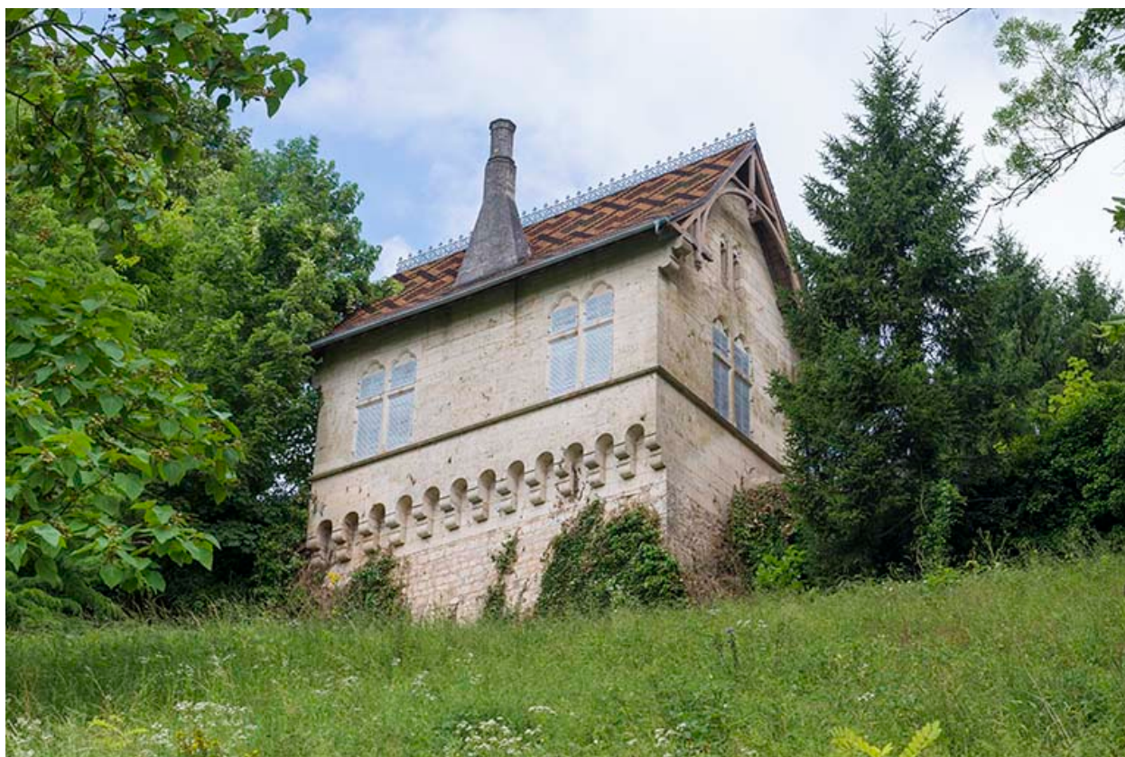
Vue générale depuis le sud, en contre-plongée.
