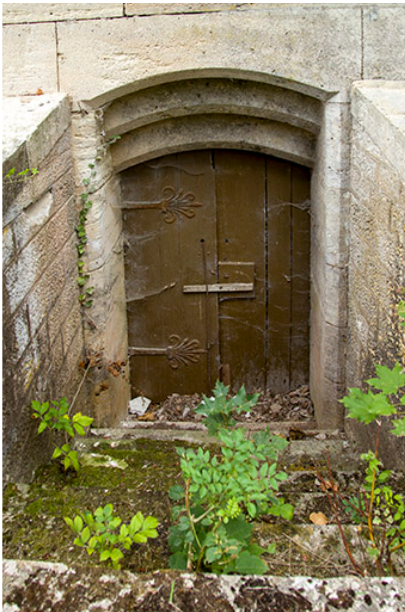
Détail : porte conduisant au sous-sol.
