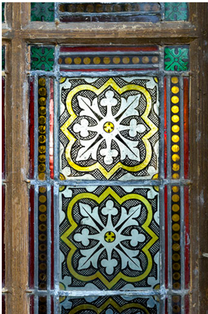
Détail d'une des verrières du rez-de-chaussée.
