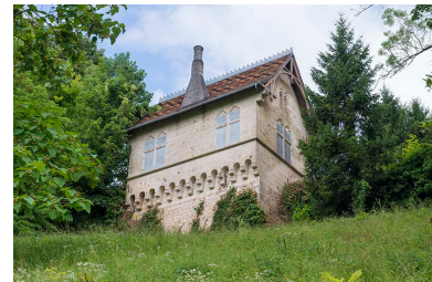
Vue générale depuis le sud, en contre-plongée.
