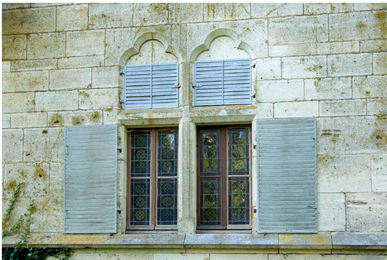
Détail : baies jumelées du 1er étage.
