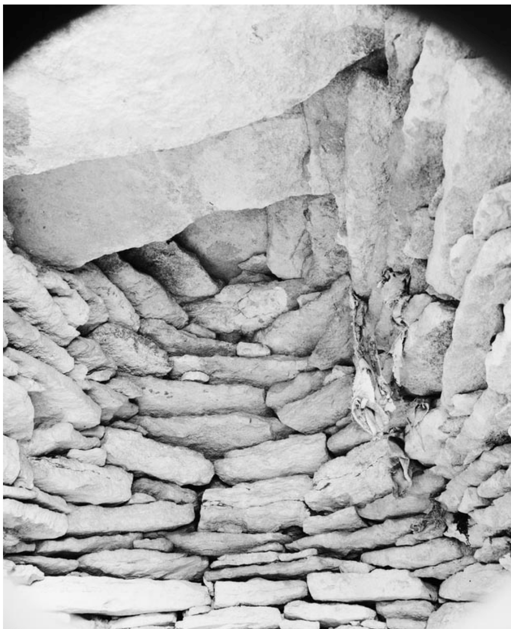
Détail de la voûte.
