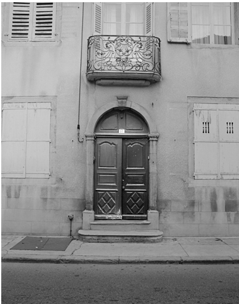
Façade antérieure, porte d'entrée et balcon.
