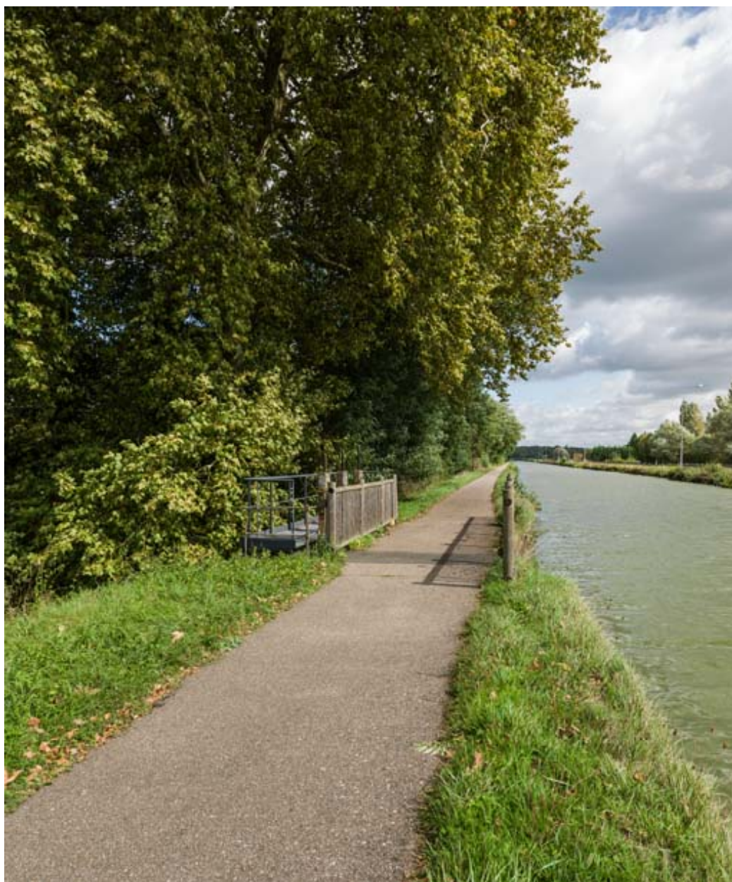
Vue du déversoir.
