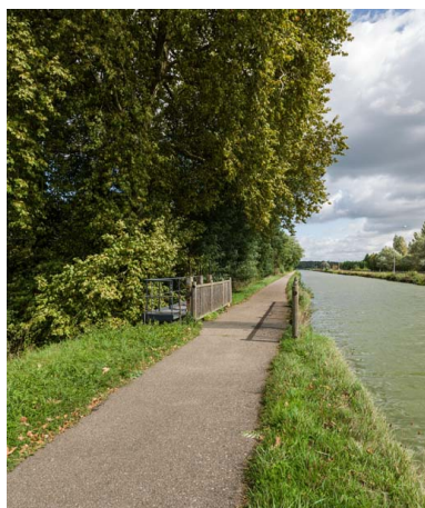
Vue du déversoir.
