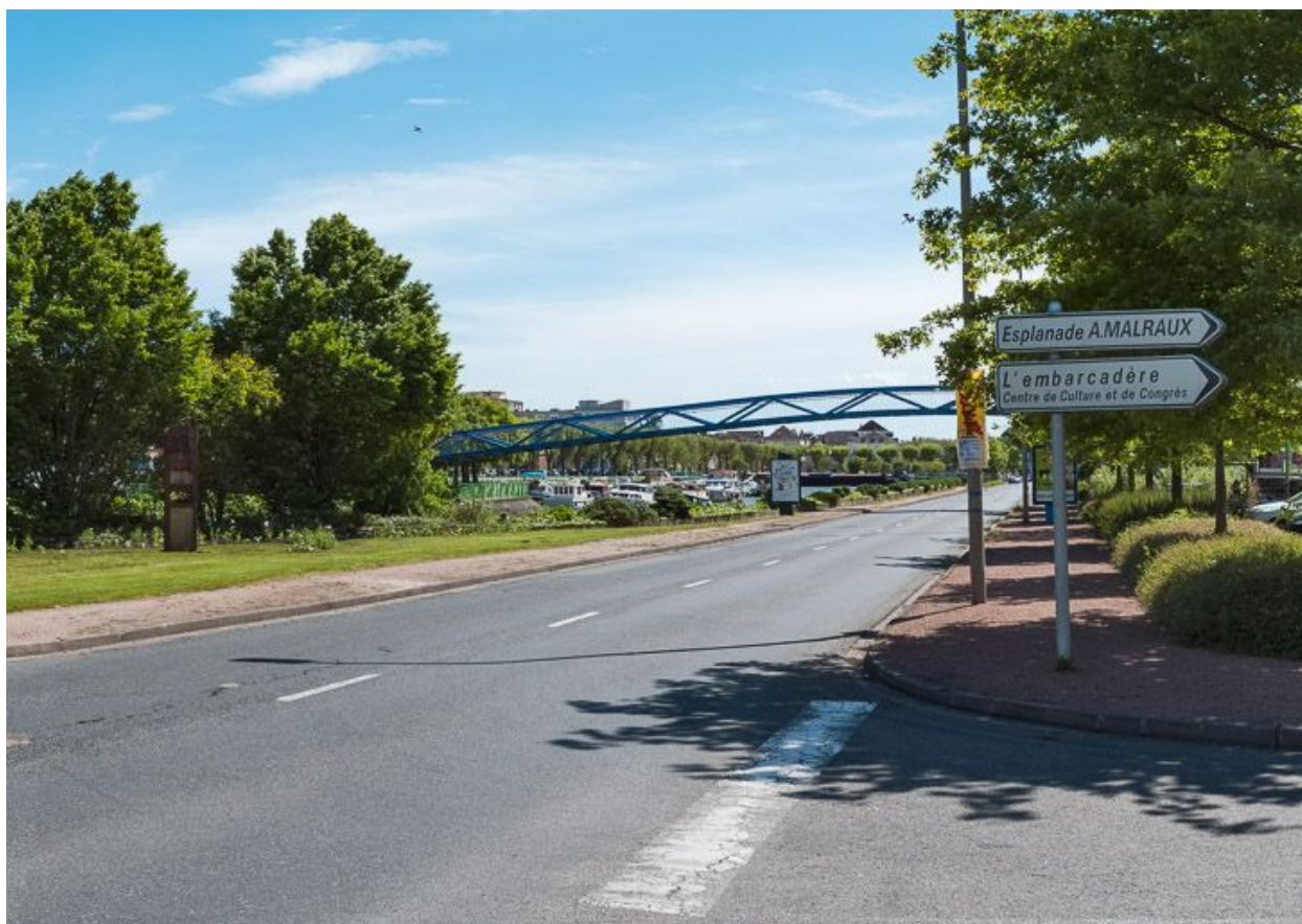
La passerelle avec le port.
