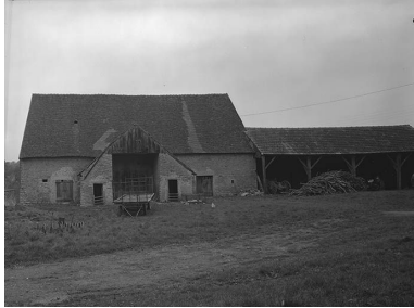
Ferme de la Commanderie, en 1975 : grange. IVR26_19755800617V
