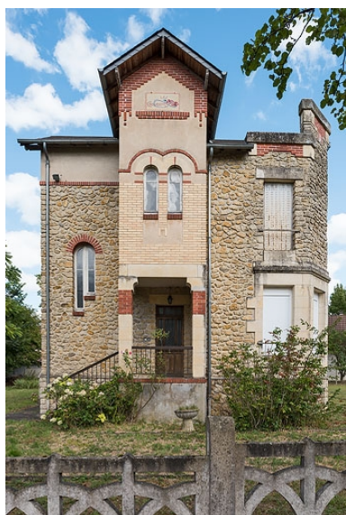
Vue depuis l'ouest.
