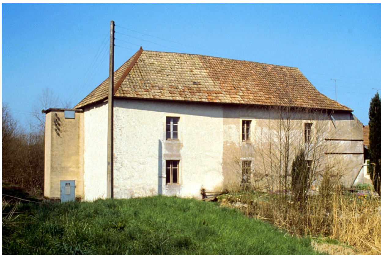
Façade latérale gauche, depuis le sud.
