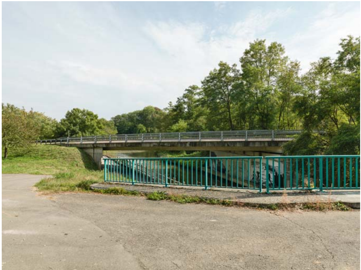
Vue d'ensemble du pont.
