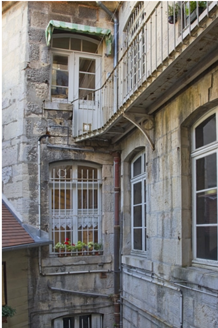
Logis : détail de la façade postérieure.
