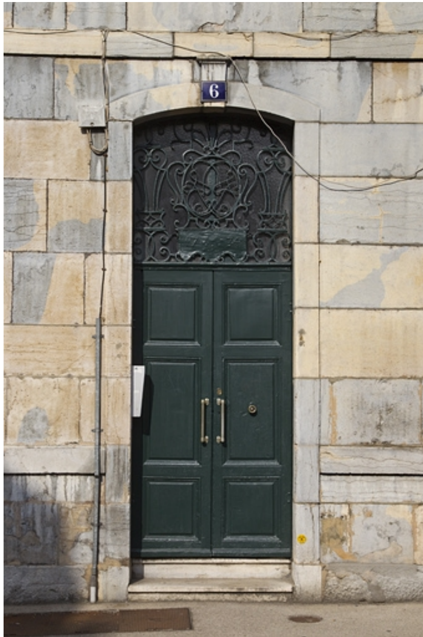
Façade antérieure : détail de la porte d'entrée.
