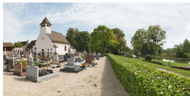
Vue d'ensemble de l'église et du canal. Phot. Pierre-Marie Barbe-Richaud IVR26_20177100468NUC2AQ
