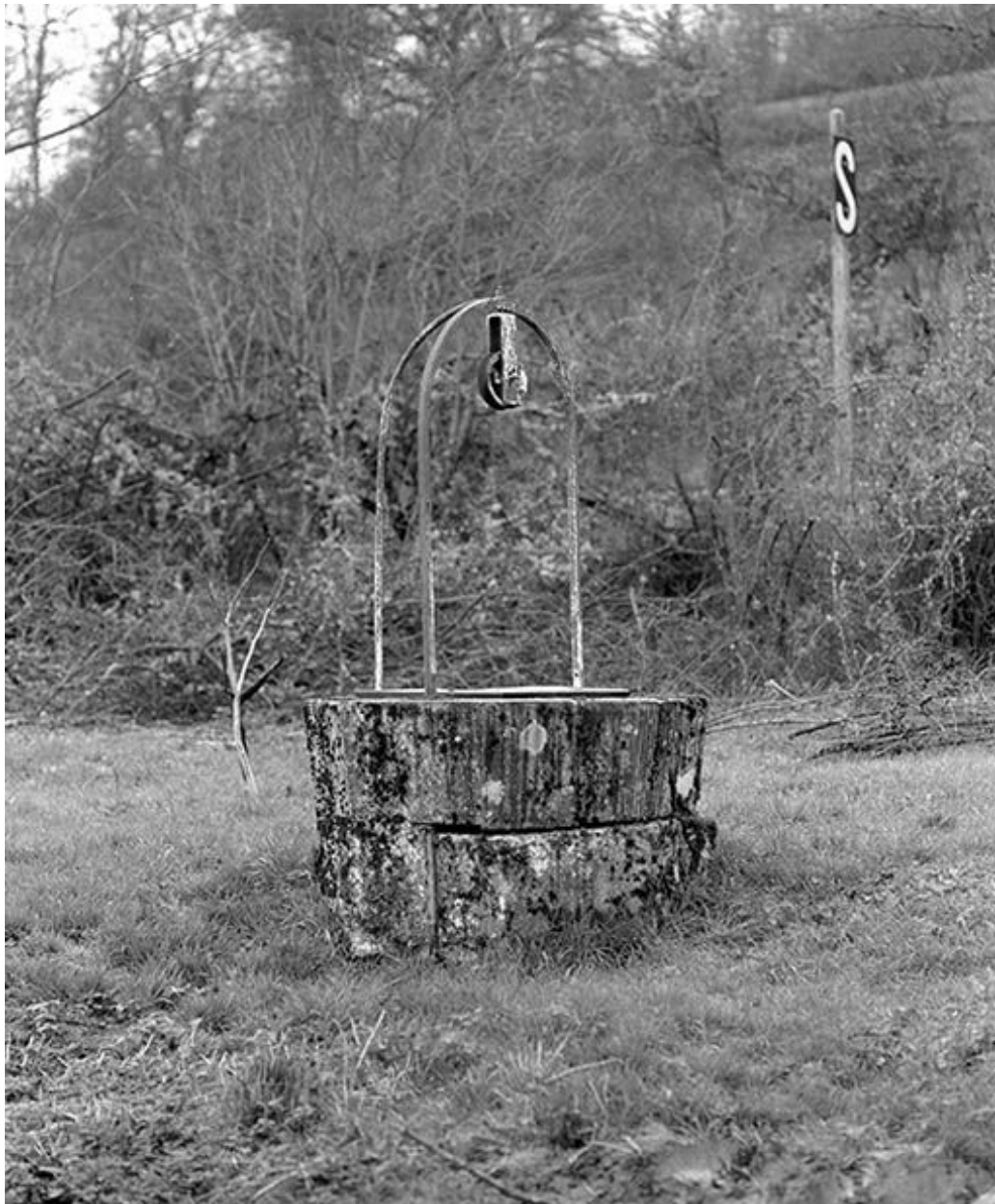
Détail du puits de maison d'éclusier.
