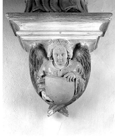
Console de gauche, vue de face. Phot. Jérôme Mongreville IVR43_19893900800X
