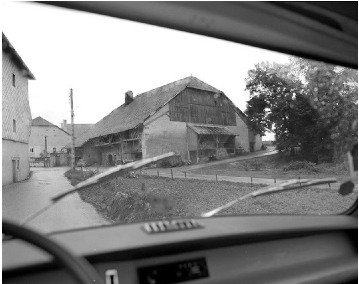
Façades postérieure et latérale droite.
