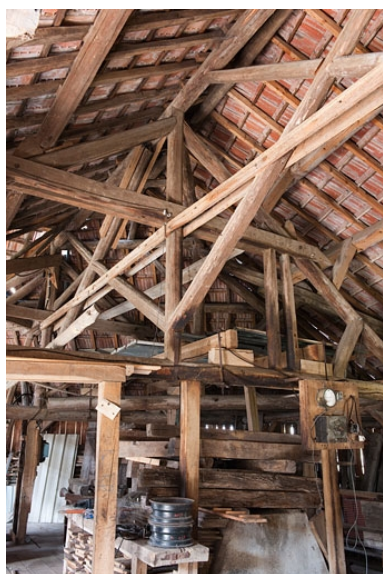
Scierie Courtot, rue du Pont : charpente. Phot. Jérôme Mongreville IVR43_20102500414NUC4A
