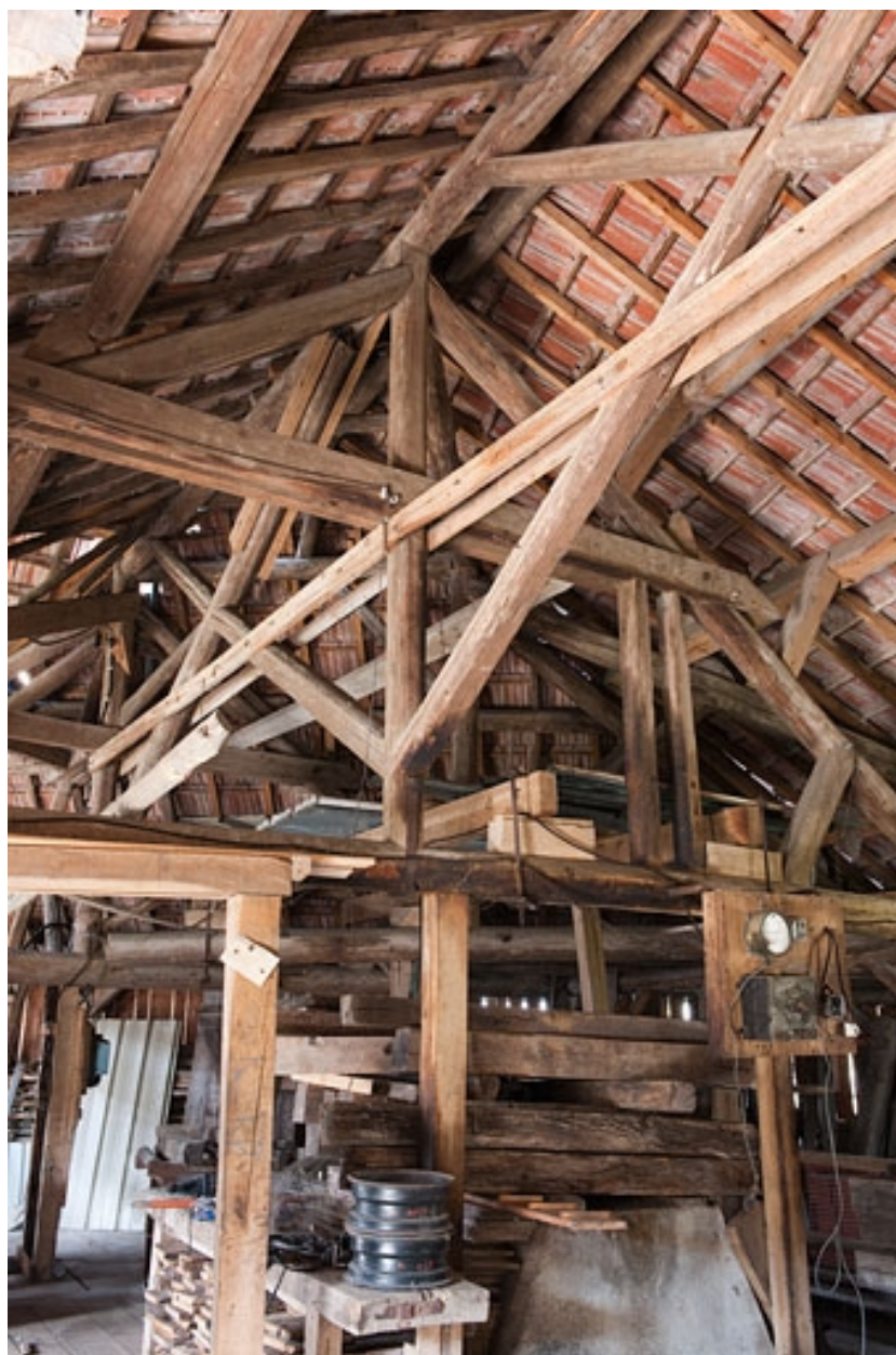
Scierie Courtot, rue du Pont : charpente.
