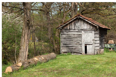
Scierie Courtot, rue du Pont : dépendance en pan de bois et essentage de planches. Phot. Jérôme Mongreville IVR43_20102500410NUC4A
