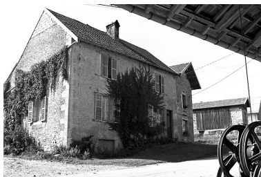
Ferme située 7 Grande Rue. Phot. Yves Sancey IVR43_19802500910X
