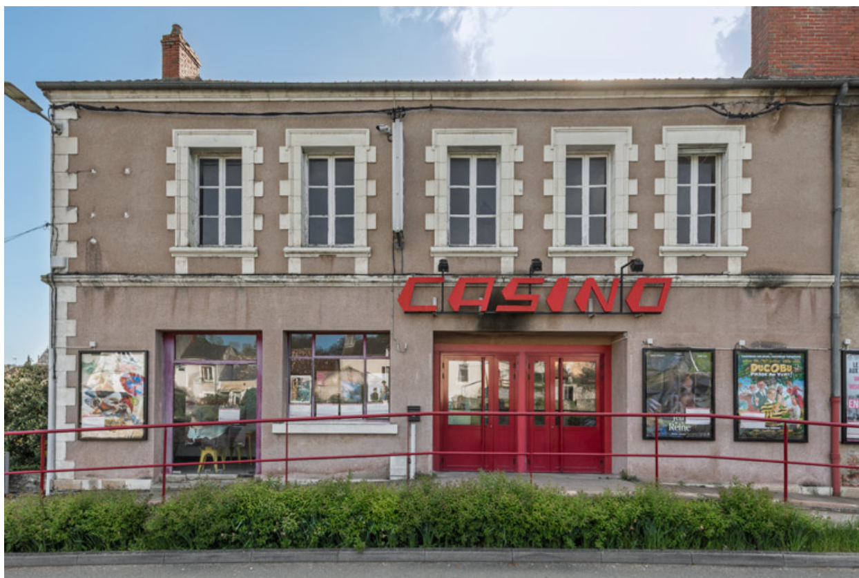
Façade antérieure, partie gauche.
