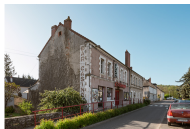
Vue d'ensemble, depuis le nord (façade antérieure). Phot. Pierre-Marie Barbe-Richaud IVR26_20245800224NUC4A
