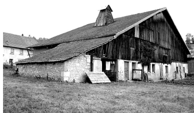
Façade antérieure. Phot. Dominique Humbert IVR43_19762500124X
