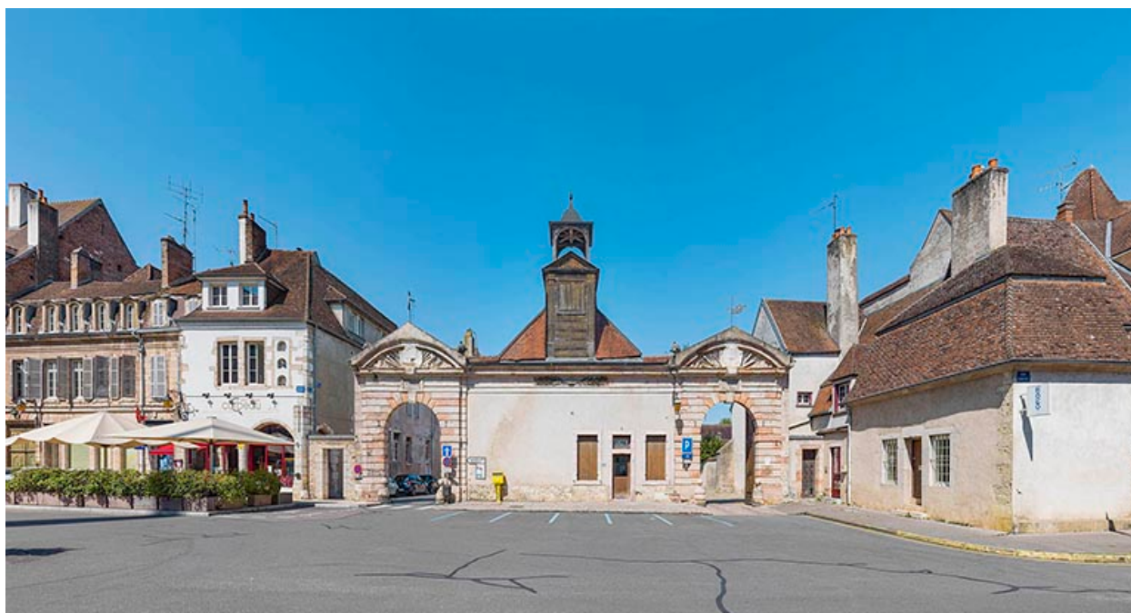
Vue d'ensemble depuis la rue Carnot.
