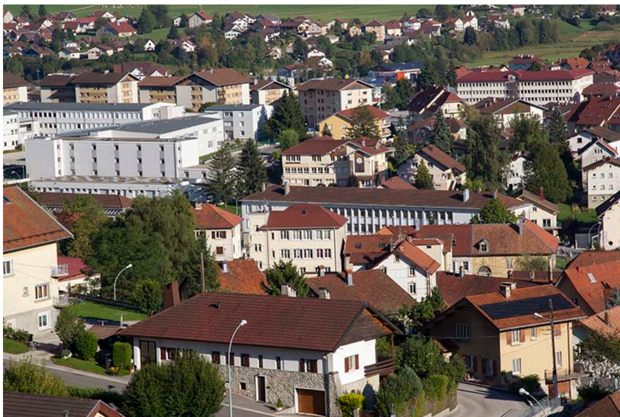
Vue d'ensemble éloignée, depuis l'ouest.
