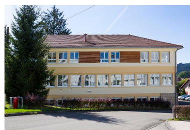
Façade latérale gauche.
