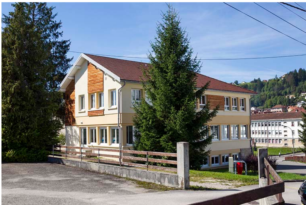
Façades postérieure et latérale gauche.
