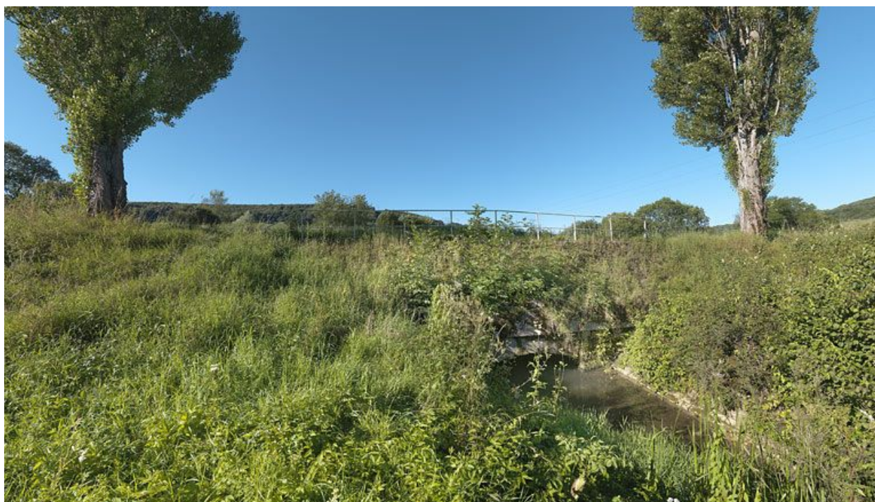
L'aqueduc du site d'écluse 16.
